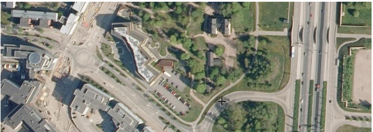
Kuva 4. Tontti talon rakentamisen jälkeen.
