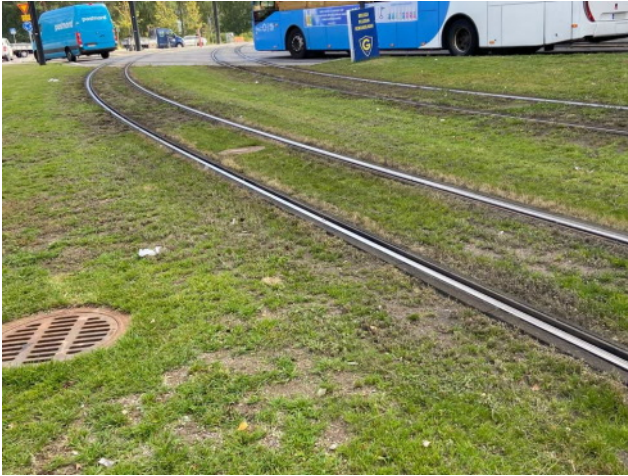
Raiteiden välit ovat haastavia kasvupaikkoja.
