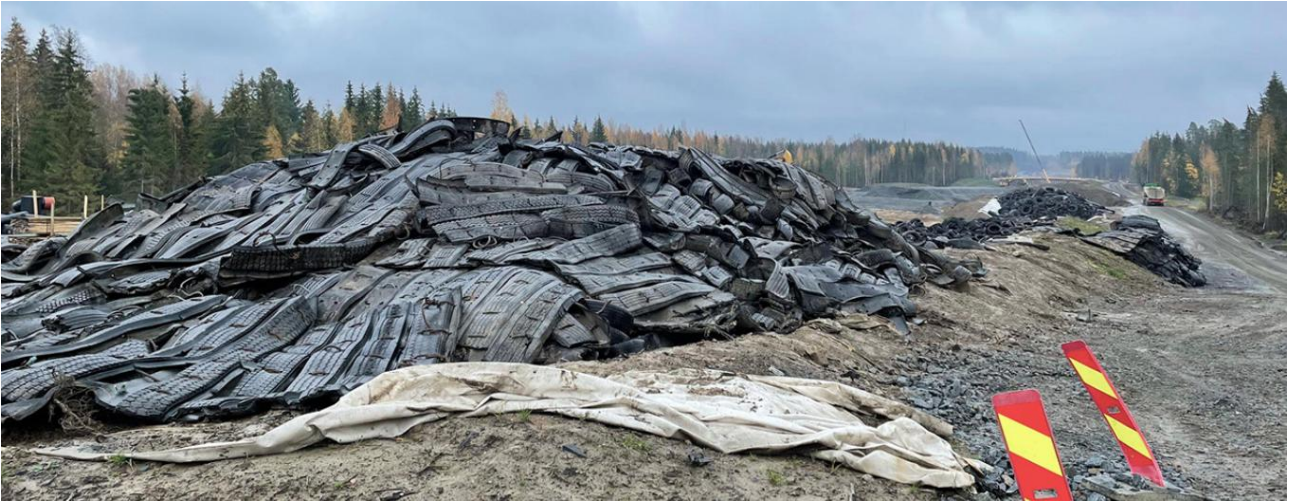
Kuva 2. Vanhat autonrenkaat meluvallissa. Hämeenkyrönväylän työmaa. (Vt 3 Hämeenkyrönväylästä tuli mallityömaa, kun kaikki halusivat kierrättää. 20.1.2022. https://vayla.fi/-/hameenkyronvaylasta-tuli-mallityomaa-kun-kaikki-halusivat-kierrattaa )
