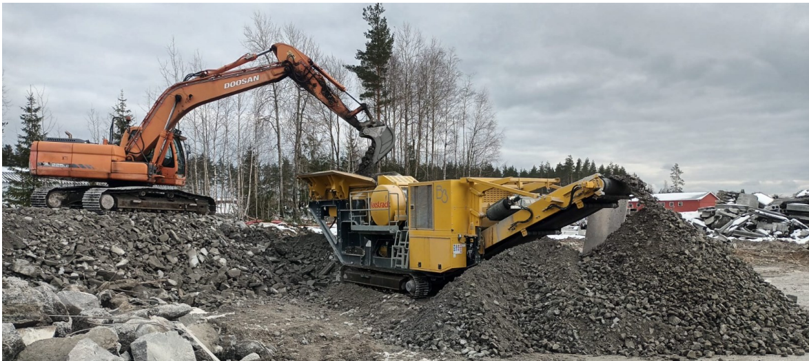
Kuva 10. Keestrack B3 -murskain ja murskaimen syöttämiseen käytettävä kaivinkone
