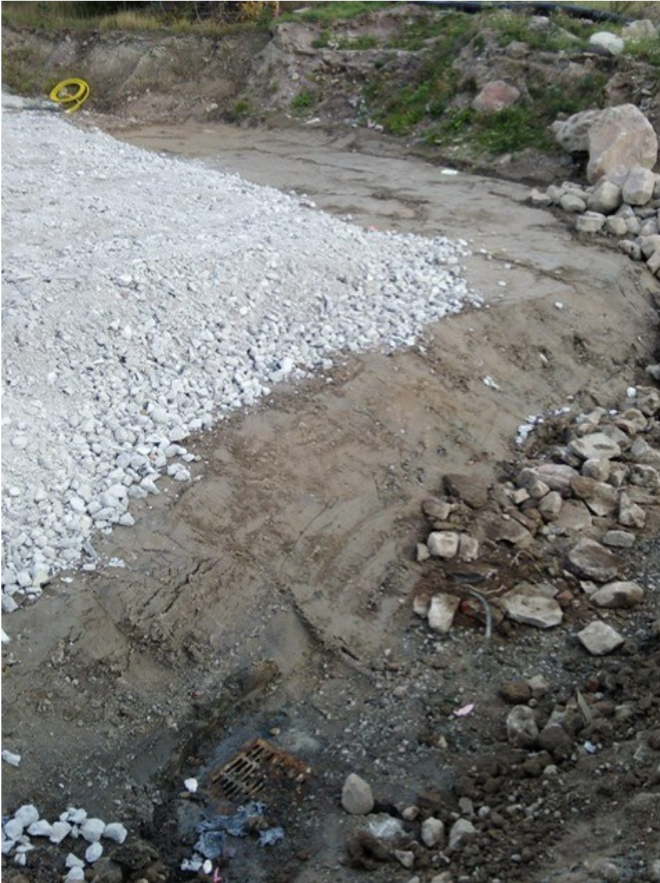
Kuva 14. Betonimurskekerros tontin piha-alueen laajennus työmaalla
