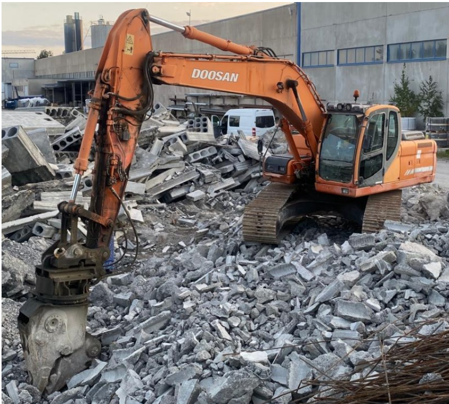
Kuva 9. Betonimurskeen esikäsitteilyvaiheessa käytettävä kaivinkone, johon on kytketty pulveroija
