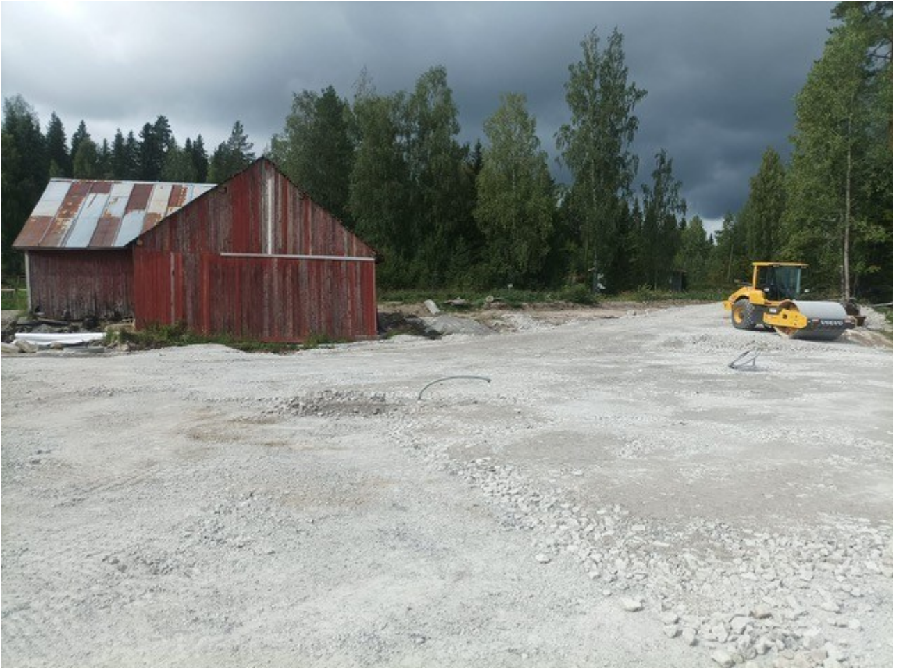
Kuva 15. Asfalttikentän pohjatyöt, jotka on toteutettu betonimurskeella
