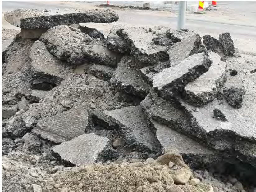
Kuva 2. Asfaltin purkutöistä syntyvä asfalttijäte
