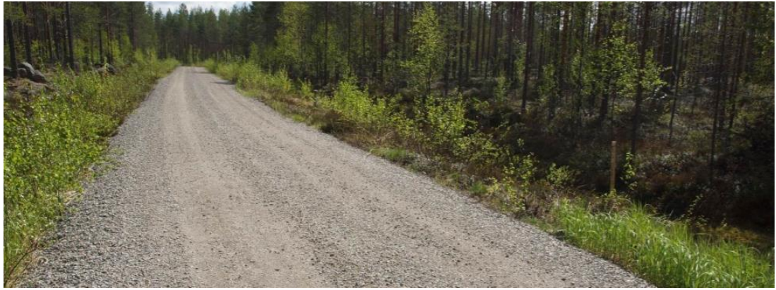
Kuva 4. Tuhkan hyötykäyttöä metsätien pintamateriaalina (Joensuu 2019)
