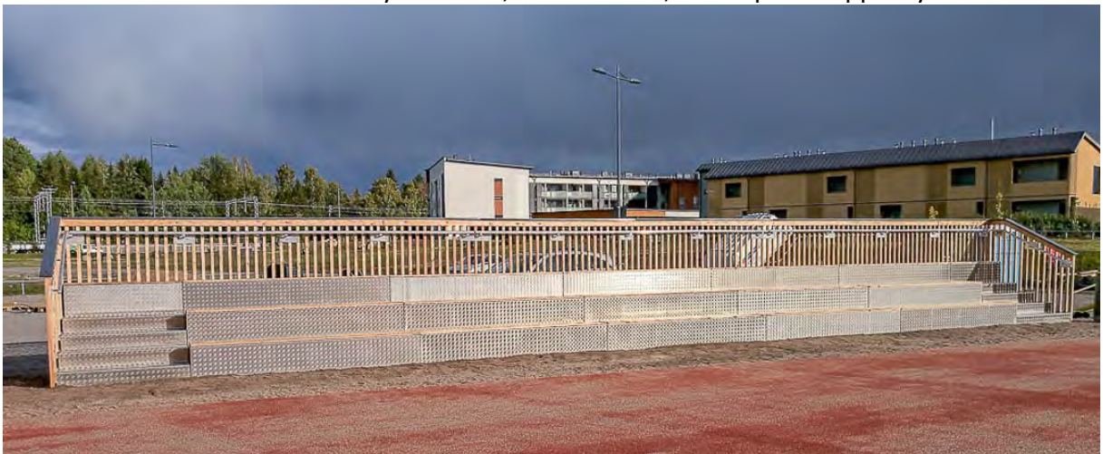
Kuva 7. Metallimoduuleista tehty katsomo, Juholanmäki, Järvenpää. Noppa Oy esite.
