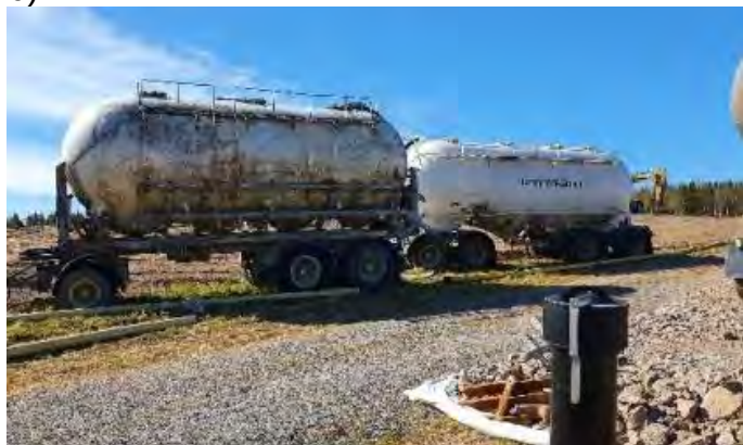
Kuva 5.5: Kuvassa a) UPM Kymmenen Jämsänkosken LT+CEM II 70/30 sideaineseos, sideaine päällisin puolin tasalaatuista. (Ikävalko 2022) b) Kuninkaantammen koestabilointialue. UPM lentotuhkan ja sementin työmaasäiliöt sideaineseosten sekoittamiseen paikan päällä (Nguyen 2021).
