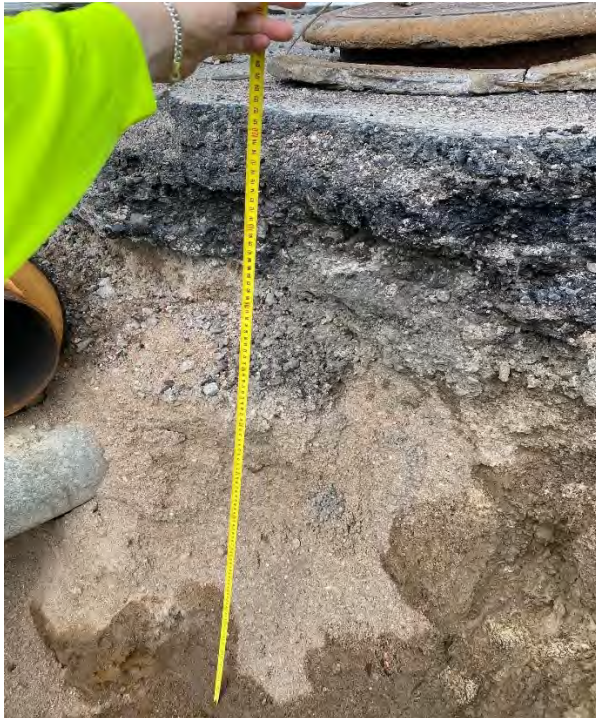
Kuva 20. Tattariharjuntien pisteen 1016 nykyiset rakennekerrokset (Ristikankare, 2024).
