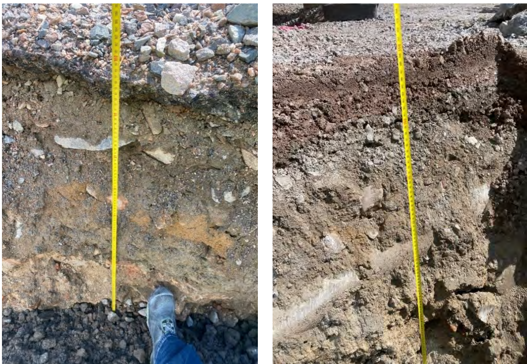
Kuva 16. Vasemmalla pisteen 1012 nykyiset rakennekerrokset ja oikealla pisteen 1013 nykyiset rakennekerrokset Katajanokalla (Ristikankare, 2024).
