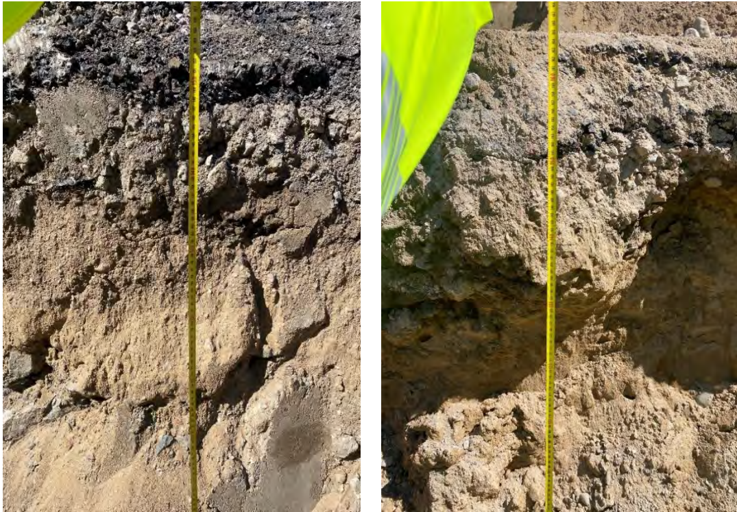
Kuva 18. Vasemmalla pisteen 1014 nykyiset rakennekerrokset ja oikealla pisteen 1015 nykyiset rakennekerrokset Porkkalankadulla (Ristikankare, 2024).
