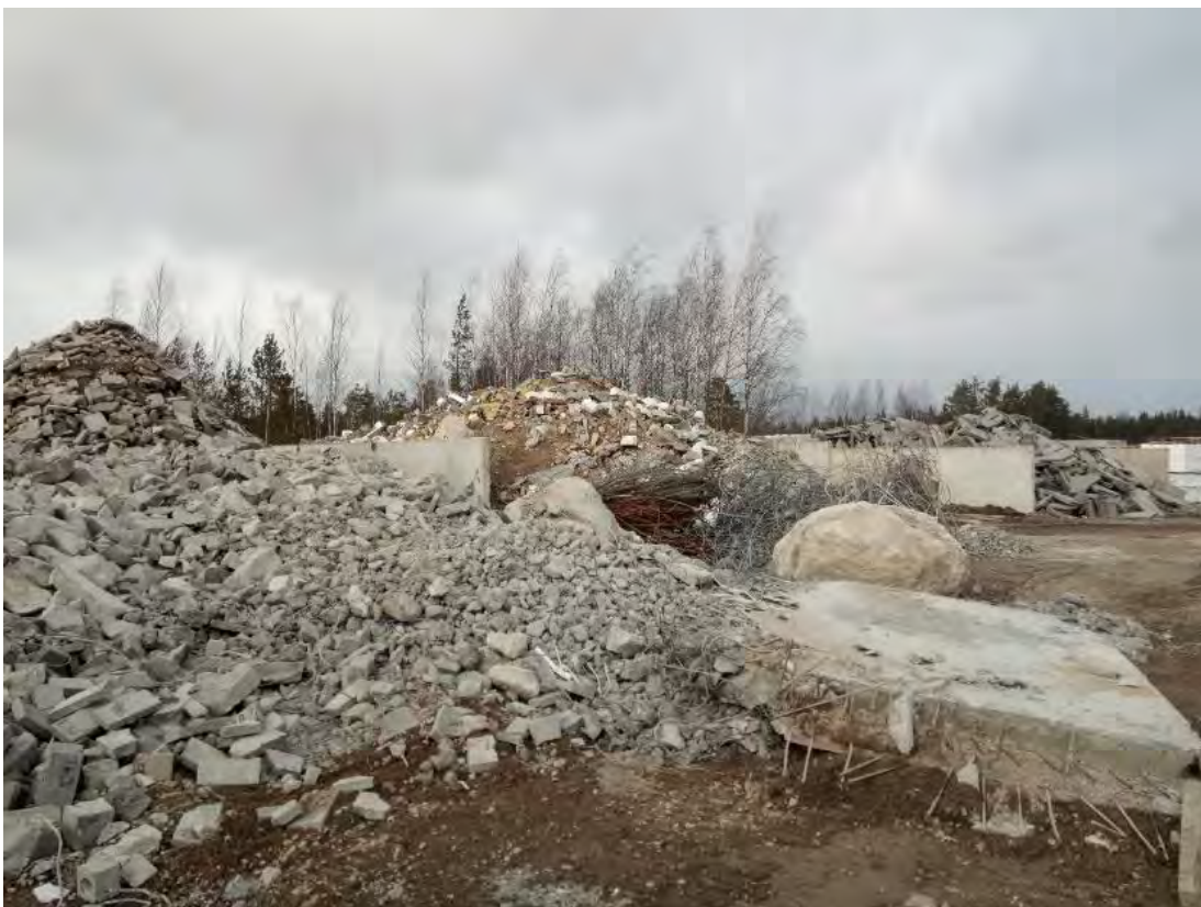
Kuva 20. Väestönsuojaelementistä eroteltuja teräsraudoituksia ja murskettä lajittelukaukaloissa
