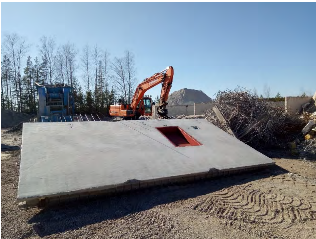
Kuva 19. Viallinen väestönsuojaelementti lajittelukaukaloiden edustalla
