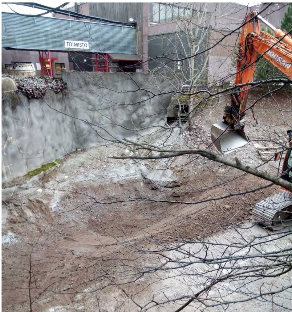
Kuva 13. Betonin kierrätyslaitoksen kierrosta poistuneiden pesuvesien tyhjennysalueen huolto
