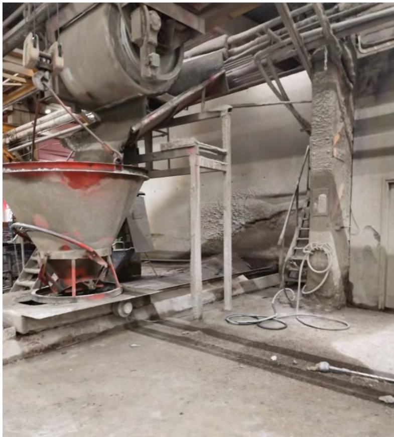
Kuva 10. Ratakuljetin purkamassa betonia betoninkuljetusastiaan pesupaikan edustalla
