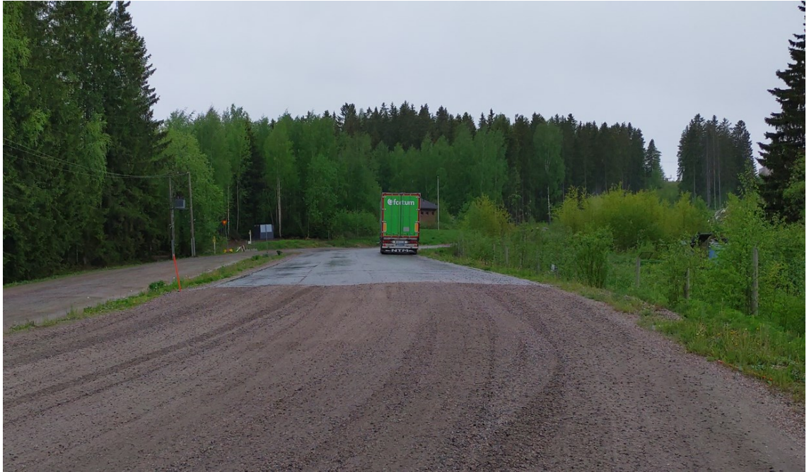
Kuva 29. Koerakenne Kuulojantiellä alkaa asfaltoidusta osuudesta.
