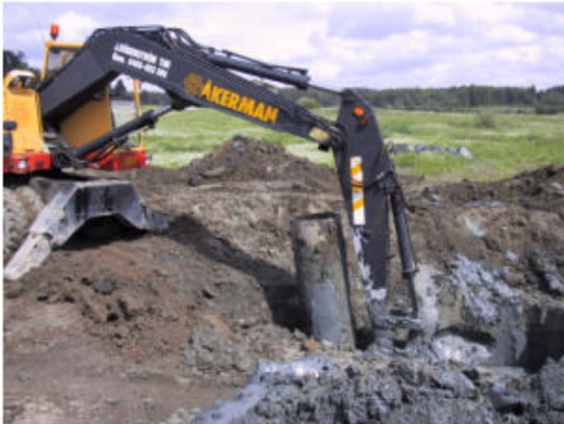
Kuva 17 Vanttila. a) Pilarin yläpään esiin kaivuu. b) Putken upottaminen pilarin ympärille. c) Putken nostaminen kaivinkoneella. d) Ylös nostettu putki ja pilari. (Aalto 2002).
