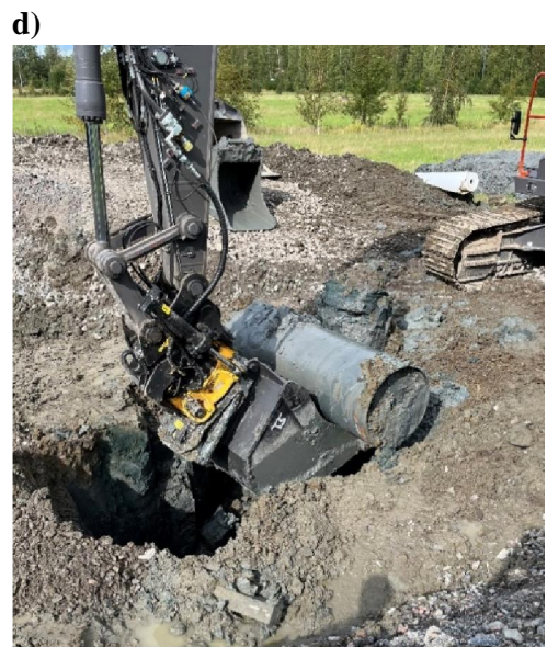
Kuva 19 a) Esiin kaivettu pilarin yläpää. b) Putken upotus maahan. c) Esiin kaivettu putki. d) Putken nosto maasta. (valokuvat Otto Kaukoranta 4.9.-7.9.2023).
