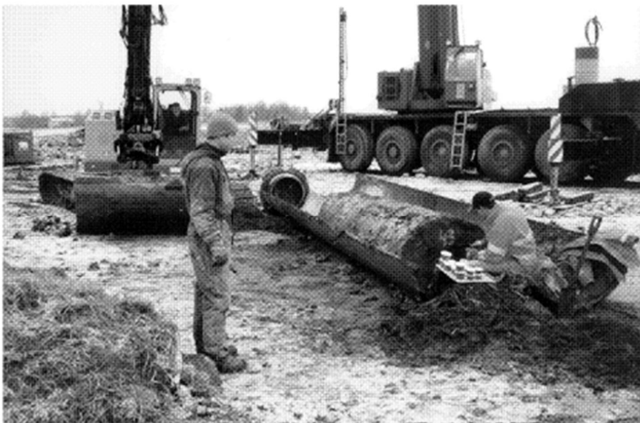
Kuva 15 Arboga, Ruotsi. Pilarin nosto halkaistavalla nostoputkella (Larsson 2003).
