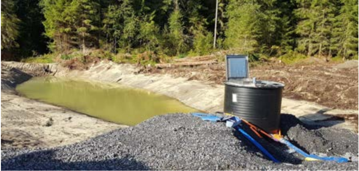
Kuva 19. Neutralointikaivo ja laskeutusallas, sekä altaan ympärillä kalkittuja maita altaan molemmin puolin.
