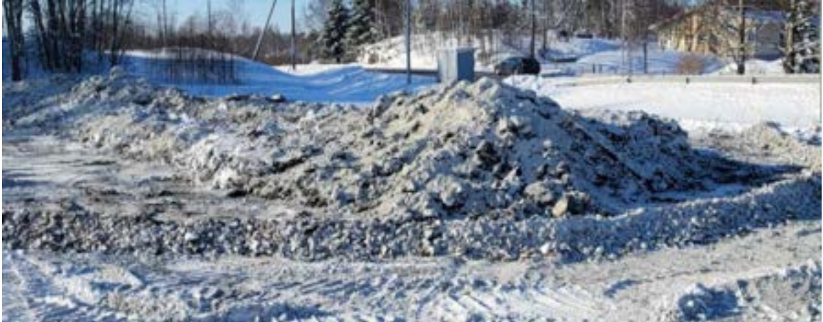
Kuva 17. Porvoon Storängsbäckenin uoman kunnostuksen aikana läjitettyä kalkittua maa-ainesta.
