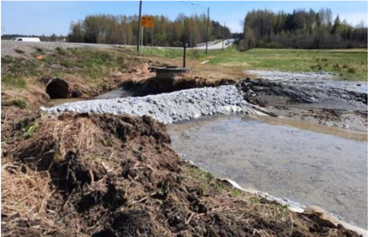
Kuva 16. Porvoon Kulloon työmaavesien hallintaan rakennettu kalkkikivipato.
