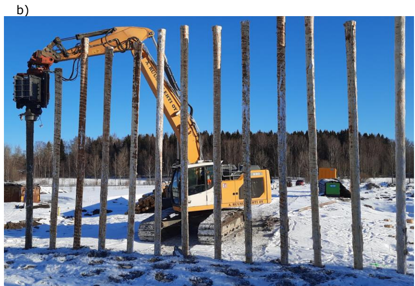
Kuva L12. Puupaalujen asennusta. a) Vuosaassa Movax-sivuoteiskijällä (kuva Kalle Rantala, Hooli 2020) ja b) Malminkentällä (kuva Ari Orttenvuori 2023).
