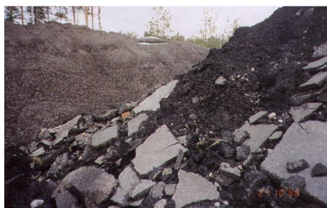
Asfalttirouhe ja pala-asfaltti
