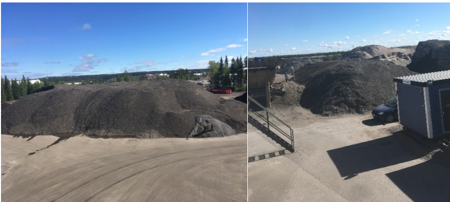
Kuva 22. Rouhekasat Rovaniemen ja Oulun asfalttiasemilla
