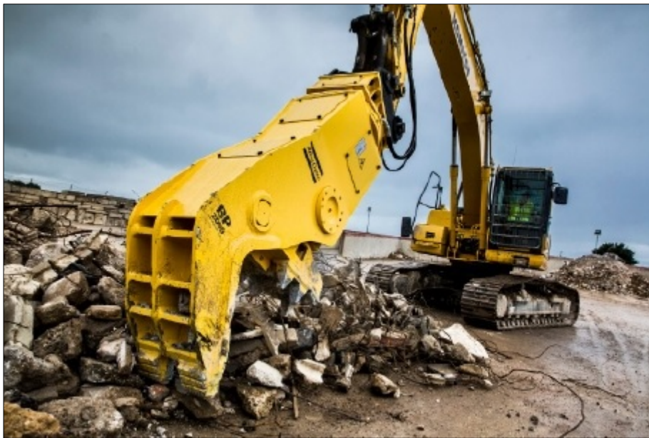
Kuva 3.4. Purkubetonin pulverointia (Atlas Copco Oy).
