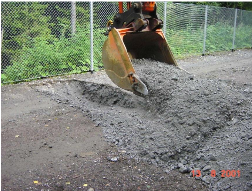
Kuva 7.16. Betonimurskerakenteen kaivu kynsikauhalla. (SCC Viatek Oy 2001)
