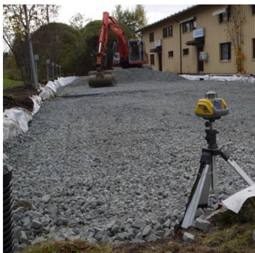
Kuva 3.9. Voimakkaasti routinut piha-/paikoitusalue korjattiin vaahtolasimurskerakenteen avulla. Vaahtolasimurske toimii uudessa tai korjatussa rakenteessa kuivattavana, eristävänä ja keventävänä kerroksena.
