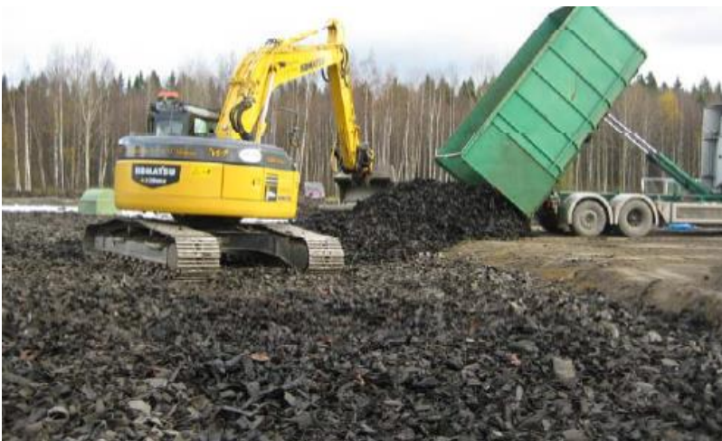
Kuva L3-2. Rengasrouheen levitystä.
