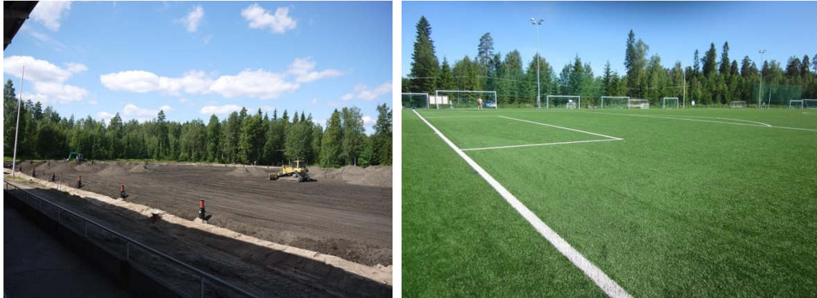
Kuva 3.5. Vanha huonokuntoinen nurmikenttä muutettiin tekonurmikentäksi (katso case-esimerkit liitteessä 3) ja uusimisen yhteydessä huonosta kuivatuksesta sekä routivasta pohjasta johtuen kentän korkeustasoa korotettiin kuitutuhkakerroksella, joka toimii routaeristeenä ja painumia vähentävänä luonnon kiviaineksia kevyempänä kerroksena.
