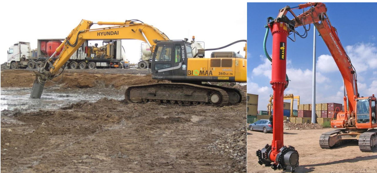
Kuvat L4-7 ja L4-8. Massastabilointilaitteisto. Pehmeä maa-aines lujitetaan (parannetaan rakentamiskelpoiseksi) syöttämällä sideainetta säiliöstä (taustalla vasemmalla) painesyöttimen avulla kaivinkoneen puomin päässä olevaan sekoitin-kärkeen ja sitä kautta maa-ainekseen.
