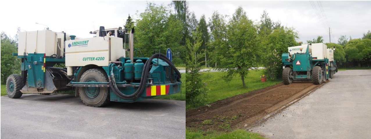
Kuvat L4-5 ja L4-6. Jyrstinsekoitus on työtapa, jolla on mahdollista rikkoa olemassa olevan rakenteen pinta ja sekoittaa vanhaan rakennemateriaaliin uutta materiaalia sekaan.
