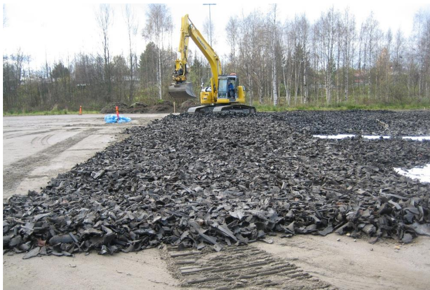
Kuva 3.3. Rengasrouheen levitystä vanhan hiekkakentän päälle. Rengasrouheen käytöllä haettiin ongelmakentälle painumia vähentävää ja kuivatusta edistävää vaikutusta, sekä jousto-ominaisuuksien paranemista. Jousto-ominaisuudet paranevat merkittävästi mikäli rengasrouhekerroksen päälle tuleva helposti tiivistyvä ja kovettuva kiviaineskerros (KaM) ei ole liian paksu.
