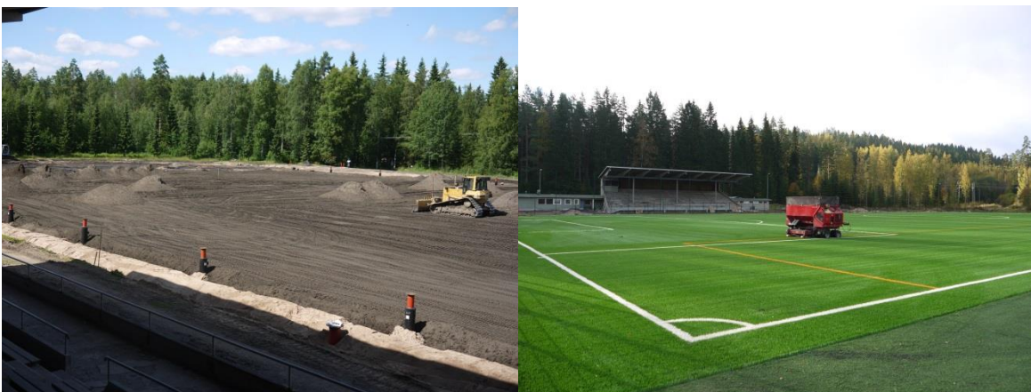
Kuvat L3-12 ja L3-13. Mäntänvuoren kentälle asennettiin kuitutuhkan ja muiden rakennekerrosten päälle tekonurmi.
