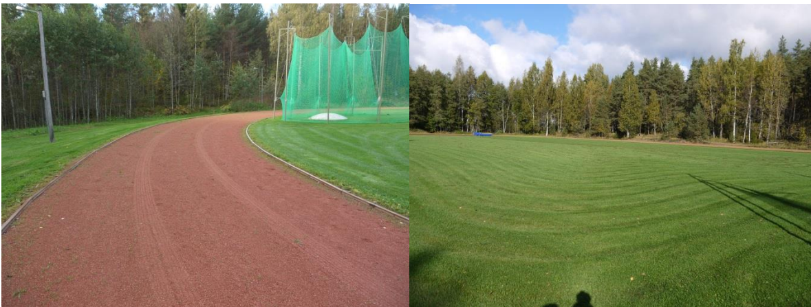
Kuvat L3-6 ja L3-7. Luopioisten urheilukenttä vuonna 2013. Luonnonnurmiäällysteinen pallokenttä, tiilimurskepintainen juoksurata ja joustava kestopäällyste-pintaiset yleisurheilun kenttälajien suorituspaikat. Rakennekerroksissa 11 vuoden ikäinen kuitutuhkarakenne kuivatusjärjestelyineen.
