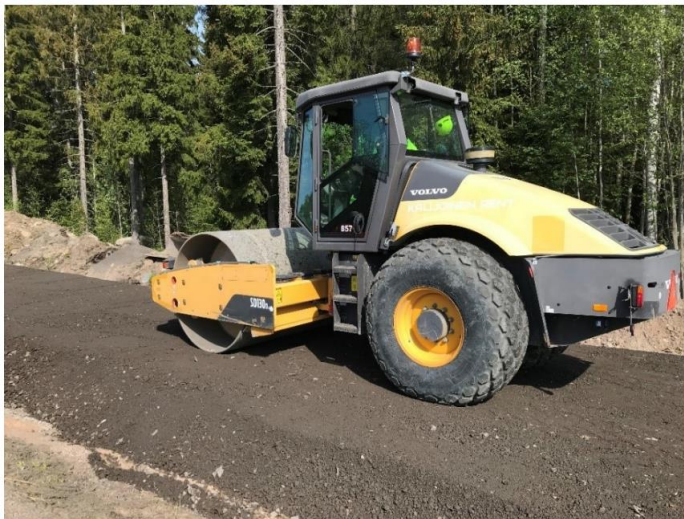
Kuva 5. Jätteenpolton kuonan koetiivistys (Matikka 2021).
