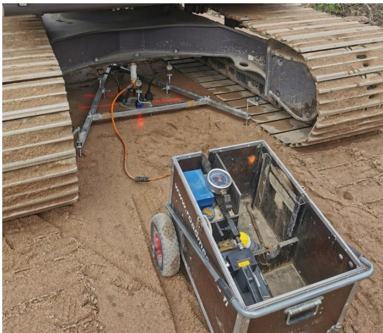
Kuva 4. Kolmen mittakellon levykuormituskoe (Matikka 2021).
