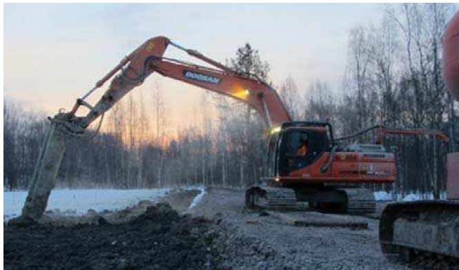
Kuva 2.2 Massasyvästabilointilaitteisto. a) Pysty akselin tai kääntyvän akselin ympäri pyörivä sekoitin ja b) vaaka-akselin ympäri pyörivä sekoitin-rumpu. Kuvat standardista SFS-EN 14679. c) Valokuva periaatekuvan kuvan b) laitteistosta (valokuva Heikki Hämäläinen). Normaalisti työ eteneen kuvien a ja b mukaisesti vasemmalta oikealle, mutta erikoistapauksissa, massastabilointi voidaan toteuttaa siten, että stabilointikone peruuttaa stabiloitavan kerroksen päällä ja tiivistyspengeri rakennetaan stabiloidun kerroksen päälle stabiloidun alueen toiselta puolelta edeten.
