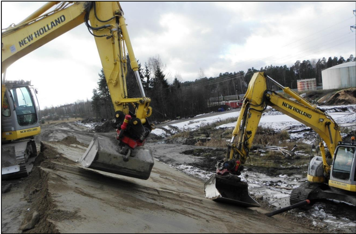
Kuva 3.5. Suojamaakerroksen rakentamista moreenista (valokuva Pekka Vallius 31.10.2012).
