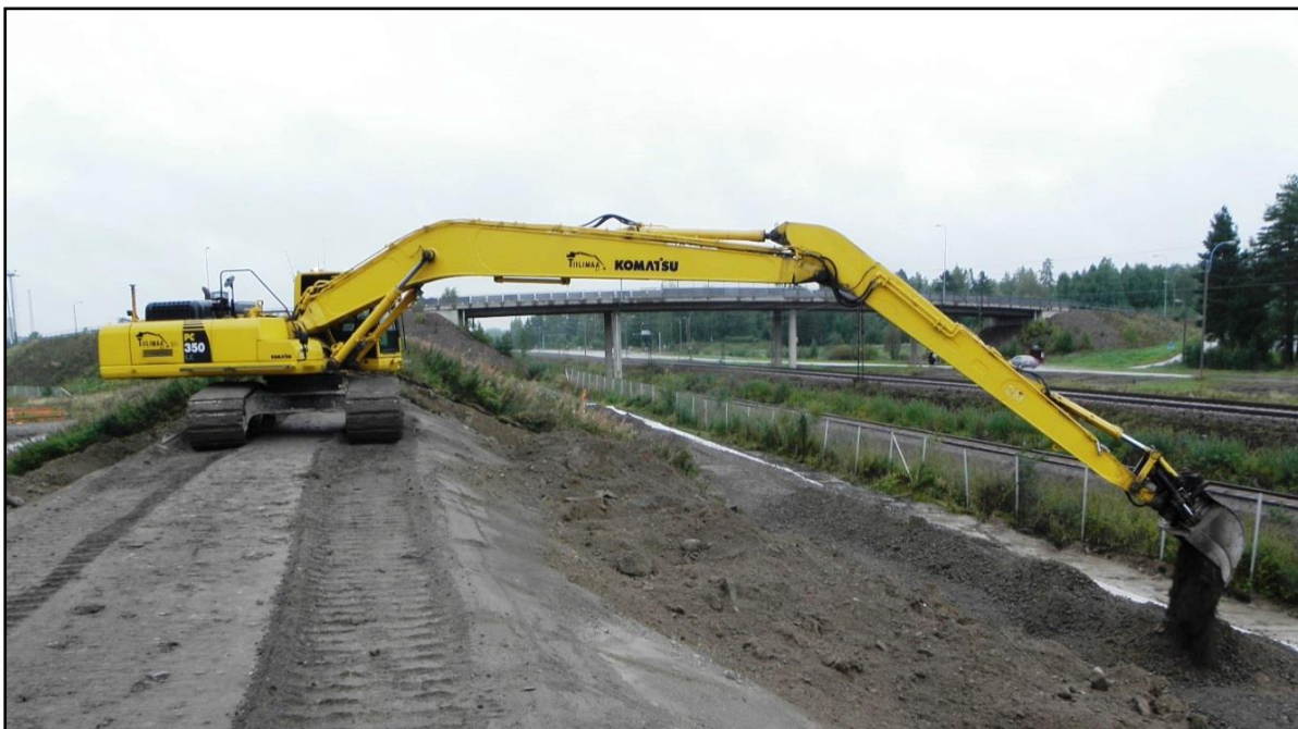
Kuva 3.6. Suojamaakerroksen rakentamista moreenista (valokuva Pekka Vallius 2017).
