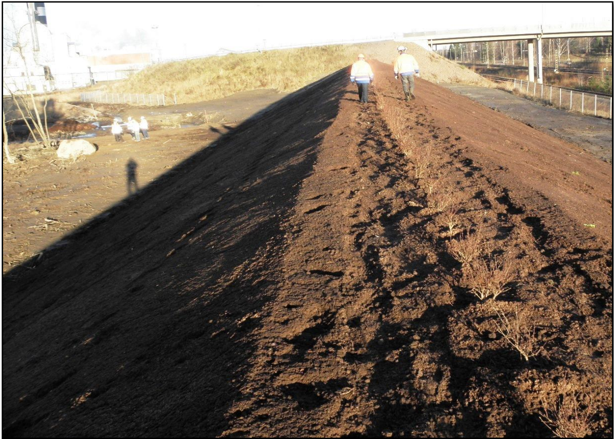
Kuva 3.7. Valmis meluvalli. Vallin pinnassa nurmetus ja päällä sinikuusamapensaat (valokuva Pekka Vallius 13.11.2012).
