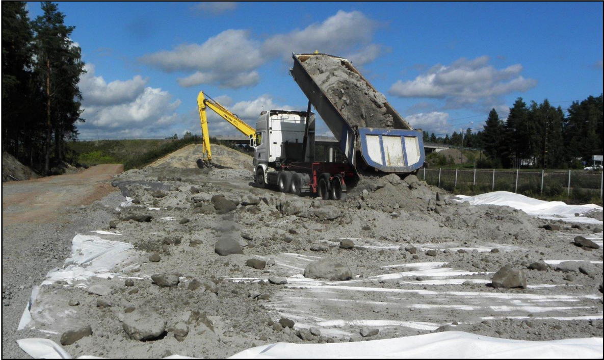
Kuva 3.3. Lentotuhkavallin rakentamista vaiheittain. Kuvassa kipataan lentotuhkaa salaojakerroksen päälle (valokuva Pekka Vallius.2017).
