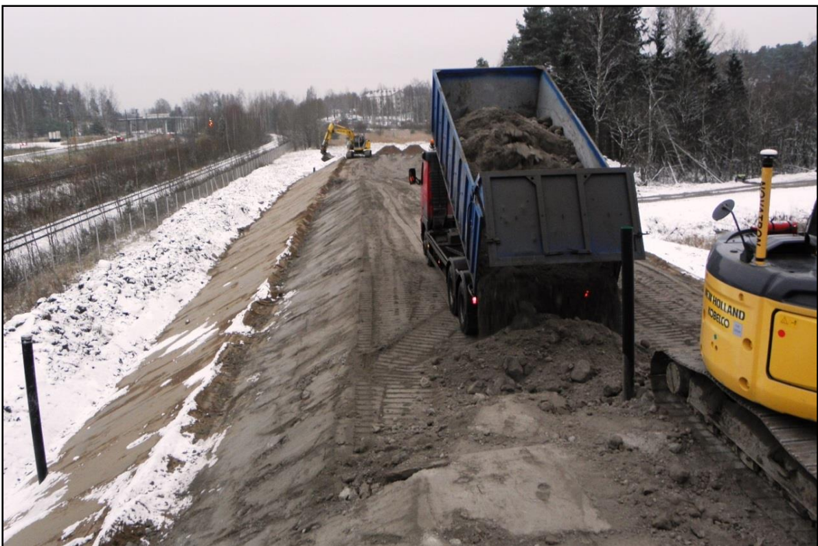
Kuva 3.4. Lentotuhkavallin rakentamista vaiheittain. Vasemmassa luiskassa lentotuhkakerroksen päälle rakennettu suojakerros. (valokuva Pekka Vallius 31.10.2012).
