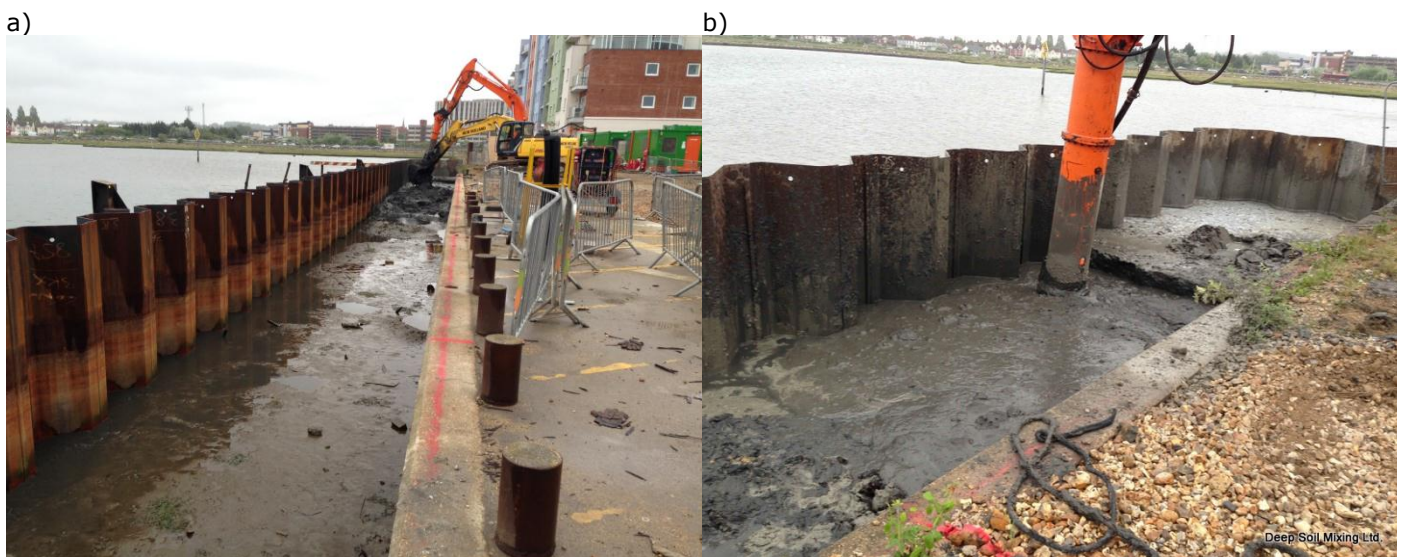
Kuva 4.10 Pilaantuneiden ruoppausmassoja sijoitettuna vanhan laiturin ja sen eteen tehdyn ponttiseinän väliin ja ruoppausmassojen massastabilointi (Deep Soil Mixing Ltd. UK).
