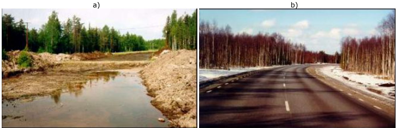
Kuva 4.2 Esimerkki massastabiloinnin käytöstä tien pohjavahvistuksena suoalueella. a) tiealue ennen massastabilointia ja b) massastabiloinnin ja päällysrakenteen rakentamisen jälkeen (valokuva: Leppänen 1995 ja 1996).
