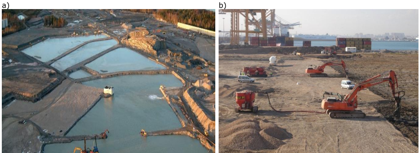
Kuva 4.9 a) Massastabilointialtaat TBT-pilaantuneen sedimentin massastabiloimiseksi (valokuva: Vuosaaren satama), b) massastabilointi käynnissä Valencian satamassa (valokuva: ALLU).
