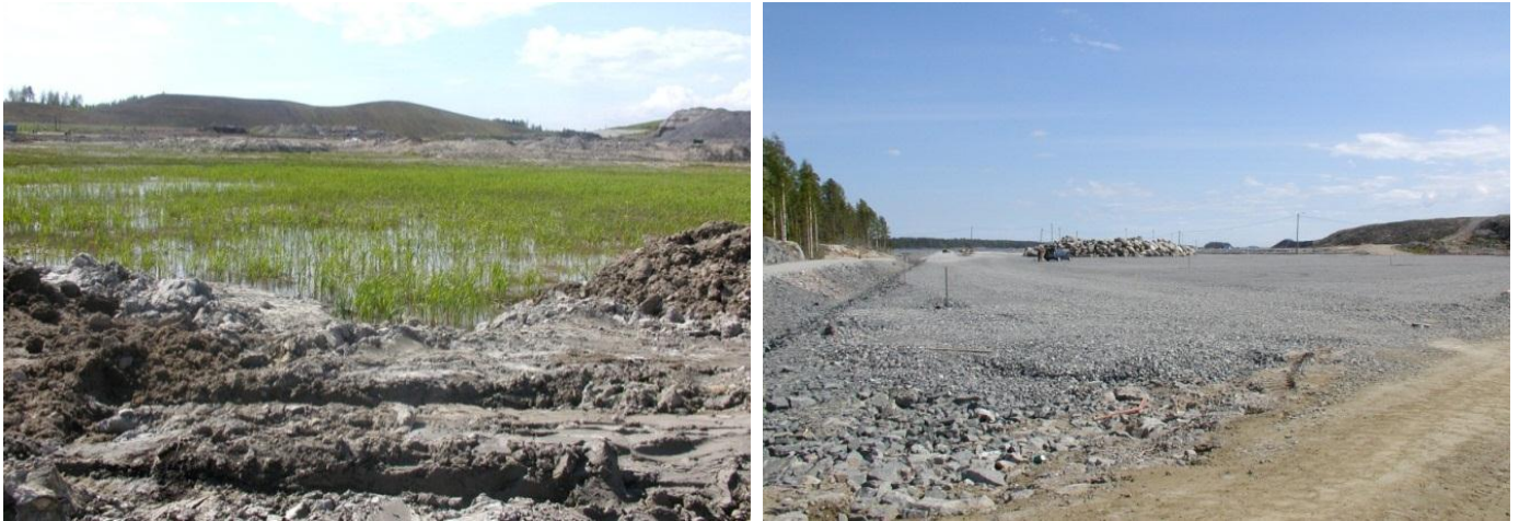
Kuva 4.11 Pehmeikköalue a) pintamaan raivauksen jälkeen ja b) massastabiloinnin ja satamakentän päällysrakenteen kantavan kerroksen rakentamisen jälkeen (valokuva: Havukainen 2004).
