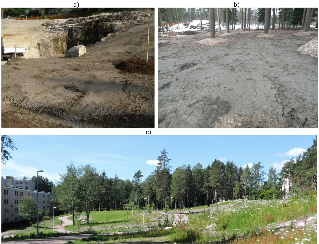
Kuva 4.13 Ida Aalbergin puisto. Syvästabiloitujen ylijäämäsavien hyödyntämistä maisemarakentamisessa (a+b) ja valmis puisto c) (valokuva: Aino-Kaisa Nuotio 2013 ja 2014).
