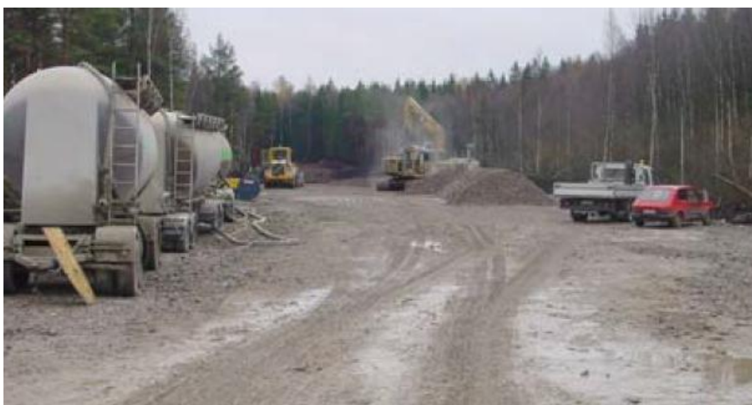
Kuva 5.1 Aluerakentamiskohde, jossa suoalue on muutettu kantavaksi ja rakentamiskelpoiseksi massastabilointia käyttäen -a) ennen massastabilointia ja b) massastabiloinnin jälkeen (Hautalahti et al. 2007).
