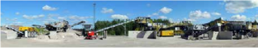
Kuva 3. SE:n jätteenpolton pohjakuonan käsittelylaitteisto © Suomen Erityisjäte Oy
