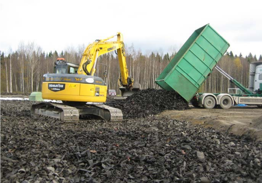
Kuva 11: Raekooltaan hienompaa rengasrouhetta RR"Hepon" levitettiin karkeamman RR300 rouheen päälle. RR"Hepon" raaka-aineena on henkilöauton renkaat ja RR300:n raaka-aineena henkilöauton renkaita isommat ja jäykemmät renkaat.
