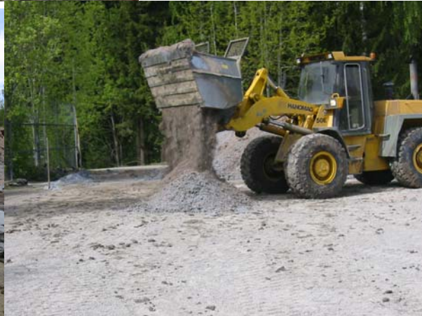
Kuvat 6: Kuitusaven ja suotokakun sekoittaminen pieneen määrään kalliomursketta eli "tiivisteiden teko". Yläkuvassa näkyy kasalla etualalla tumman harmaata suotokakkua, sen takana vaalean harmaata kuitusavea ja takana kalliomursketta (ruskea).
