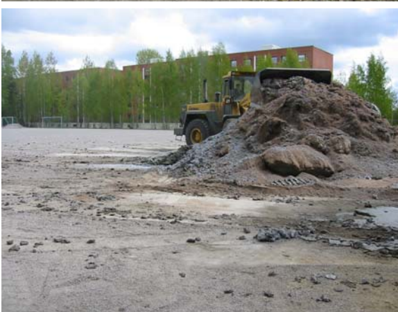
Kuvat 6: Kuitusaven ja suotokakun sekoittaminen pieneen määrään kalliomursketta eli "tiivisteiden teko". Yläkuvassa näkyy kasalla etualalla tumman harmaata suotokakkua, sen takana vaalean harmaata kuitusavea ja takana kalliomursketta (ruskea).
