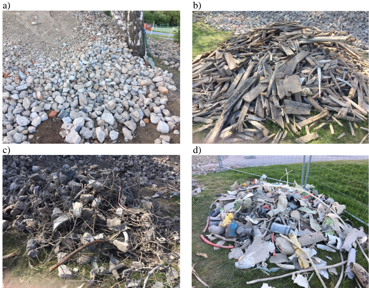
Kuva 2. a) Purkukohteessa murskattua tiiltä sisältävää betonimurskettä ja purkujätteestä eritelty b) puu, c) metalli ja d) muovijäte.
