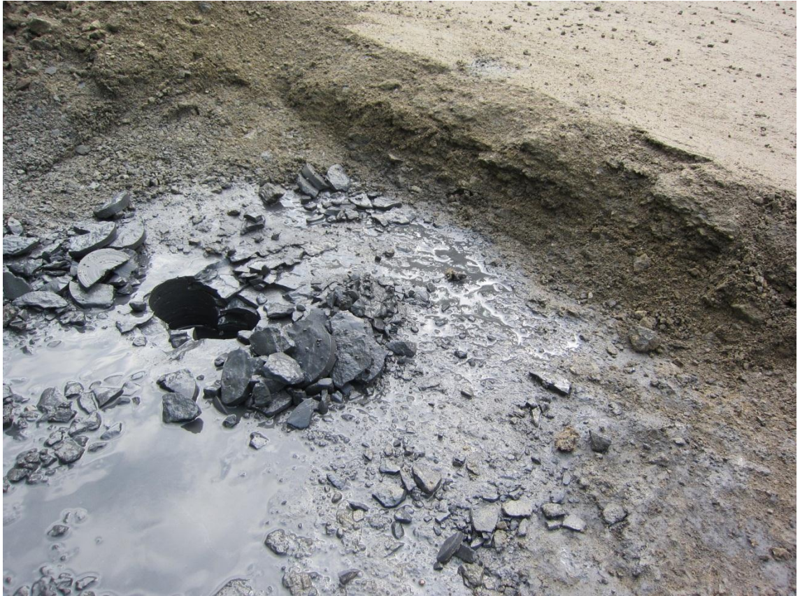
Kuva 6.30. Korian koekohteessa paalulla 1245, tuhkarakenteen 1 alueella tehdyssä rakennetutkimuksessa saatuja koekappaleita
