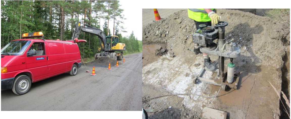
Kuva 5.2. Rakennetutkimusten tekoa kesällä 2013
