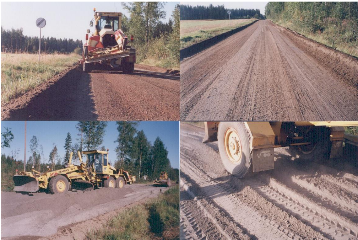
Kuva 4.10. Tiehöylän toimintaa tuhkarakenteen rakentamisessa Metsäkulmantiellä. (Kuva: Jyrävä, H.)
