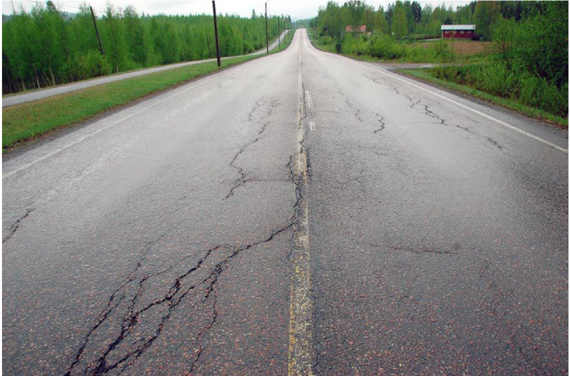
Kuva 4.5. Tyypillinen näkymä tiellä 16563 ennen korjauksia. (kuva: Kiviniemi, 2010)
