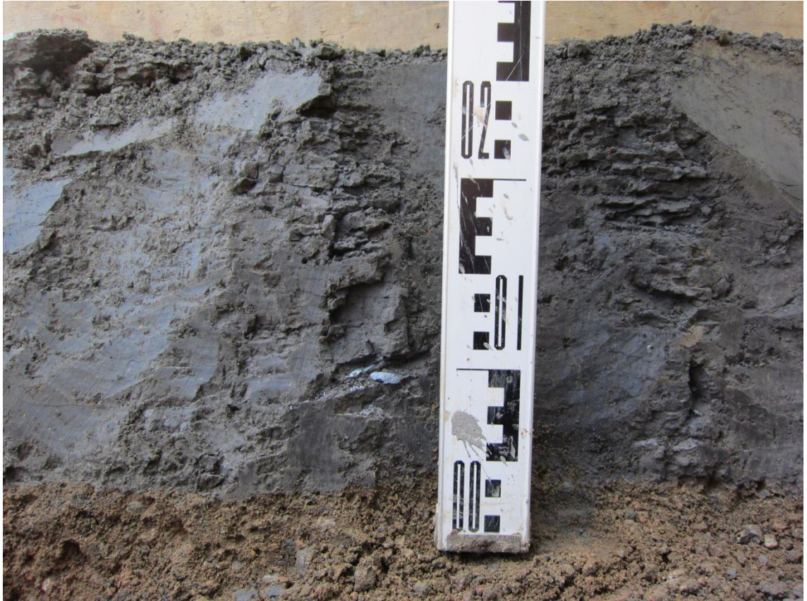
Kuva 6.31. Tuhkarakenteen 2 poikkileikkaus Metsäkulmantiellä paalulla 1735
