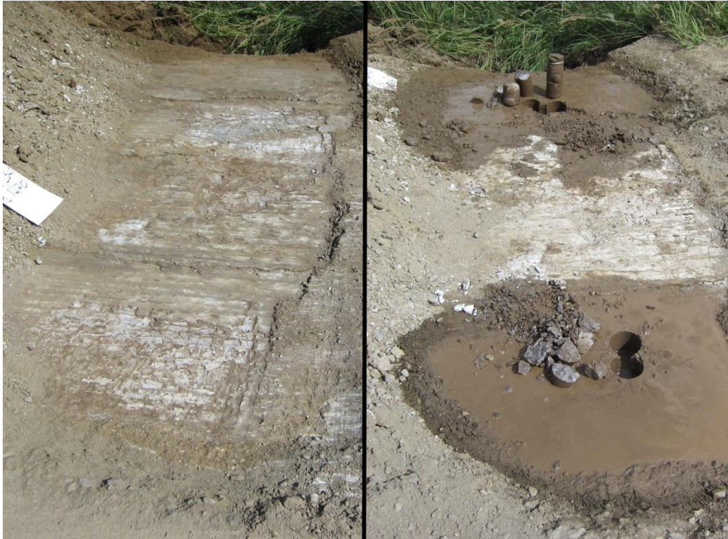
Kuva 6.46. Leppävirran koekohteessa paalulla 1270 esiin kaivettu tuhkarakenne ennen ja jälkeen näyttekappaleiden porauksen
