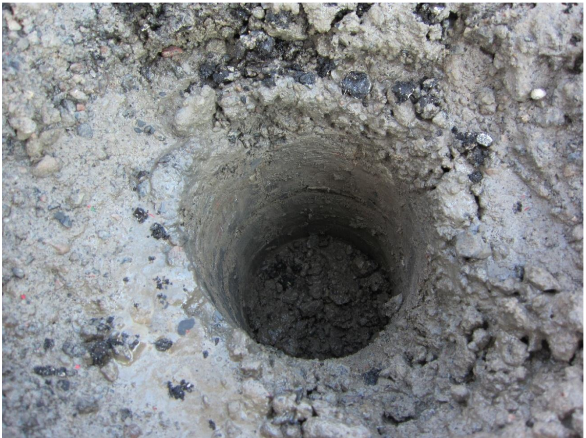
Kuva 6.8. Paalulle 910 tehty kerrosstabiloidun kantavan kerroksen tutkimusreikä.
