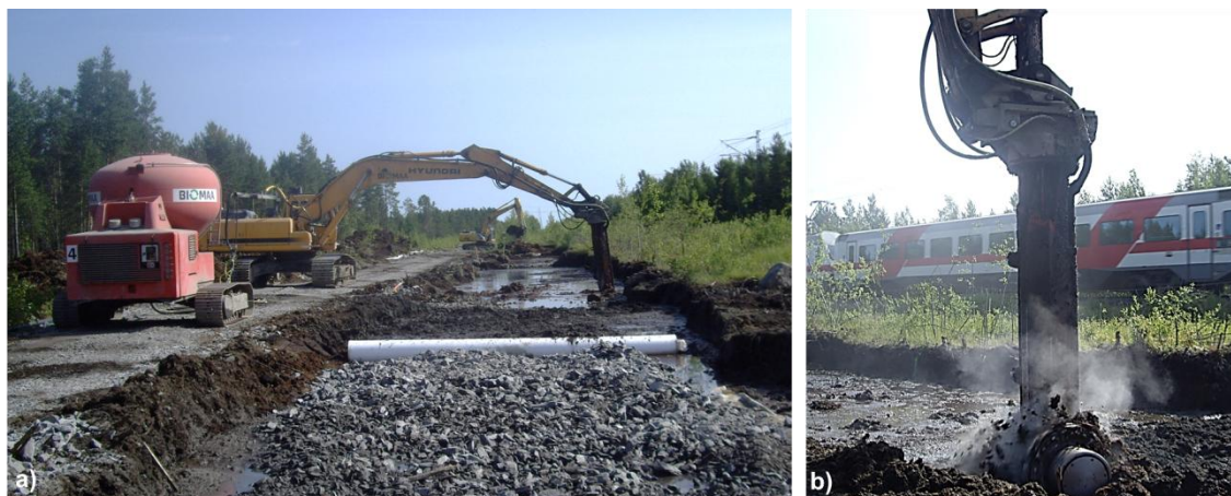
Kuva 12 a) Massastabilointikalusto; b) sekoituspuomi. (kuvat: Ville Niutanen)
