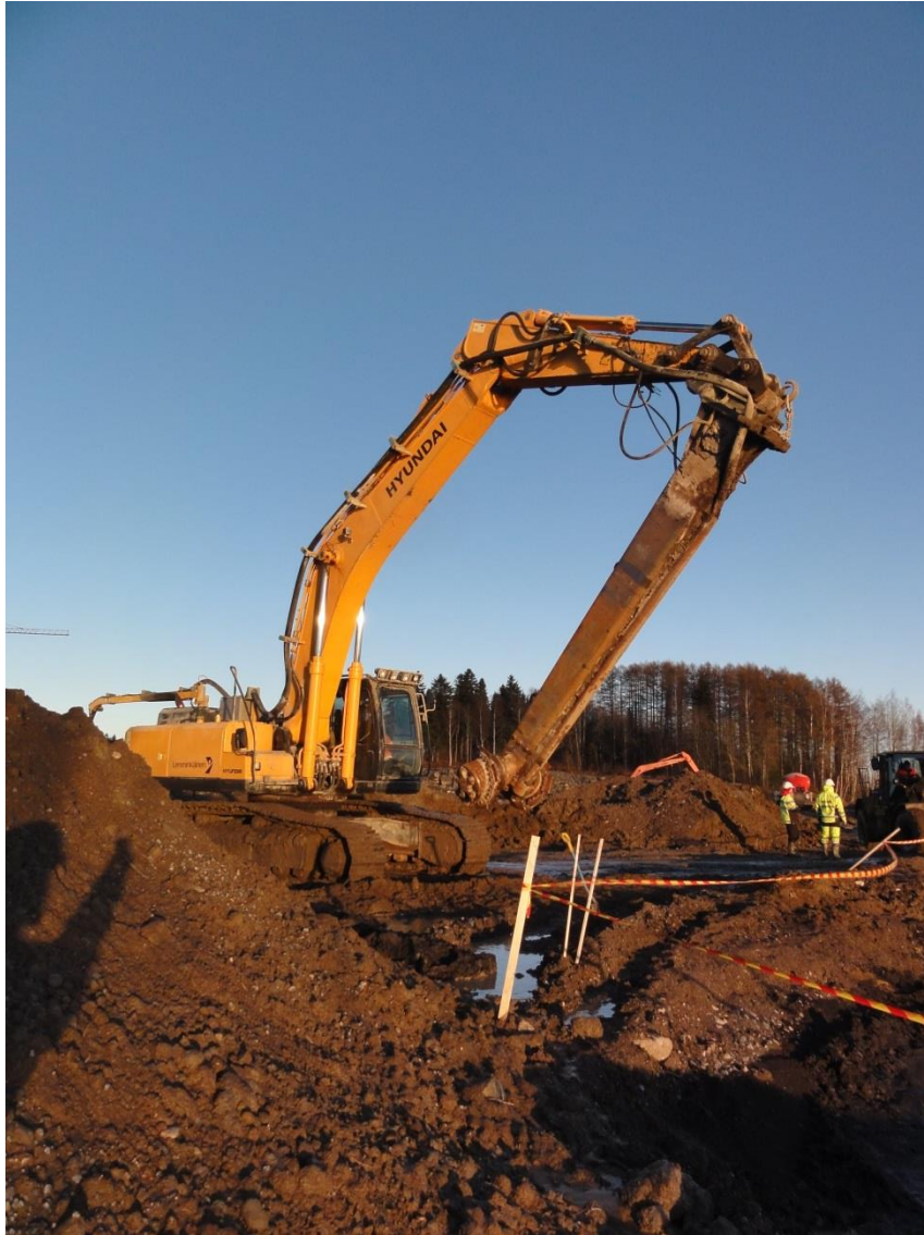
Kuva 8.7. Sekoitinkärjellä varustettu kaivinkone.
