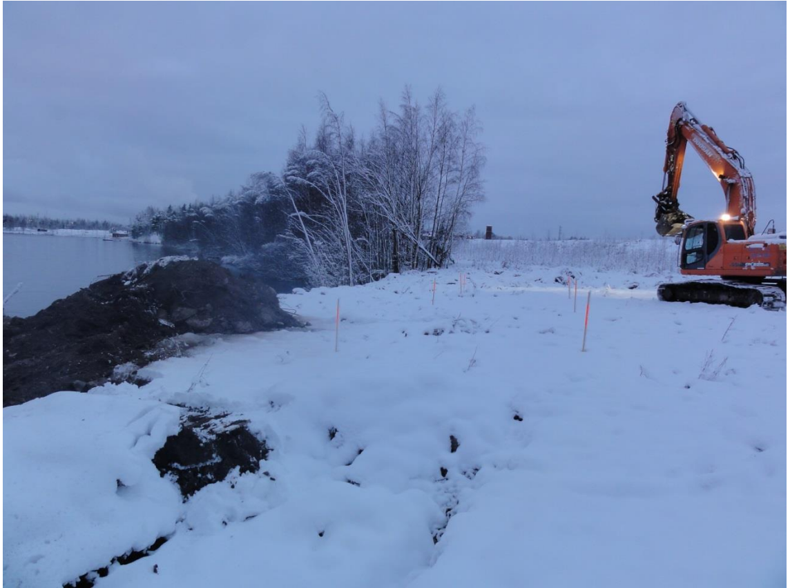
Kuva 8.1. Koestabilointikohde sijaitsee Niemenrannassa nykyisellä täyttöalueella. Kuvassa lähtötilanne 23.11.2015, jolloin altaiden kaivuluiskien alakulmat oli merkitty maastoon.
