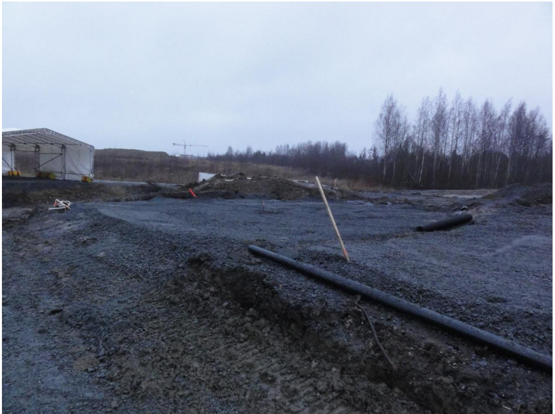
Kuva 8.11. Stabiloidun massan päälle rakennettiin tiivistyspenger murskeesta. Kuvassa etuoikealla allas 1 ja suoraan edessä allas 2.
