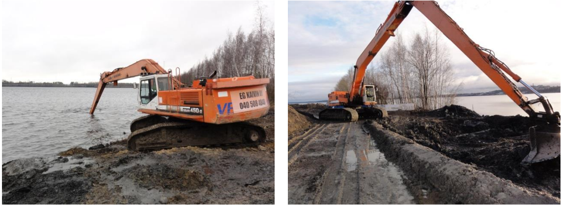
Kuva 8.6. 0-kuidun ruoppausta Näsijärvestä stabilointialtaaseen.
