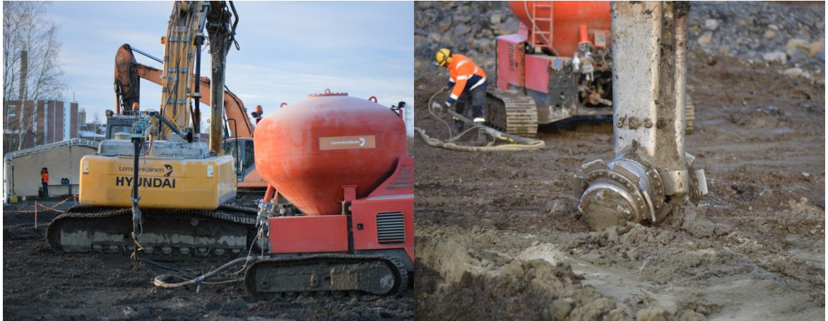
Kuva 8.9. Sideaine syötettiin sekoitinkärkeen säiliöstä painesyöttimen kautta. (Kuvat: Juha Nikkilä, 8.12.2015)
