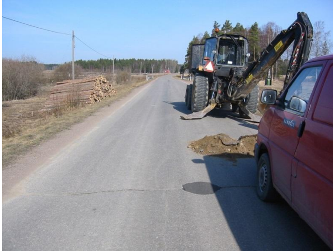
Kuva 8. Koekuoppatutkimus Teuroisten (Yt 14547) koerakennuskohteella (Ramboll 2005).
