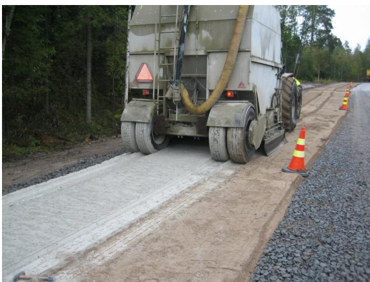
Kuva 3. Kuivan sideaineen levitys Hanhikempin koerakennuskohteella (kuva: Jokinen 2007).
