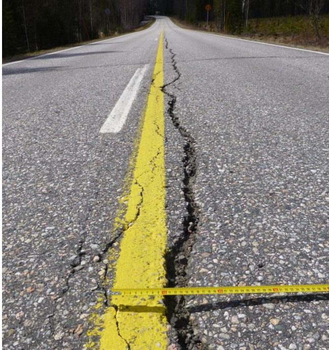
Kuva 23. Keskisaumahalkeama Rautavaaran (Kt 87) koerakennuskohteella (22.5.2017, Ilari Harju).
