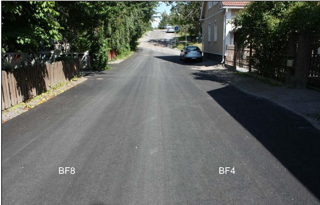
Kuva 22. Koekohde: vasemmalla BF8 ja oikealla BF4 -massalla päällystetty kaista. Vasemmanpuoleiselle kaistalle kulkeutuu hiekkaa kadun päässä sijaitsevalta päällystämättömältä alueelta.
