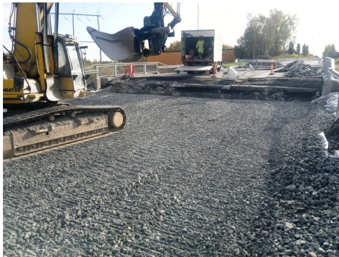
Kuva 6. Vaahtolasimurskeen tiivistys tela-alustaisella kaivukoneella (Vaasan kaupunki, 2011)
