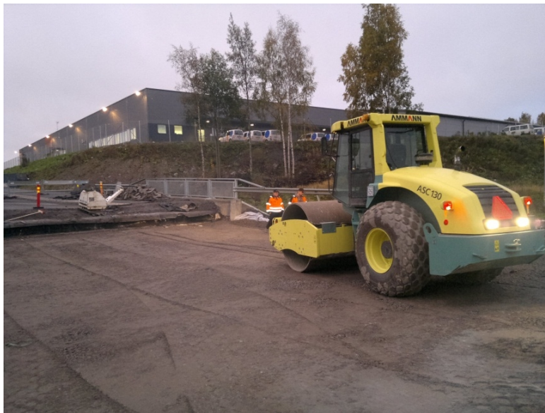
Kuva 7. Vaahtolasimurskeen lopullinen tiivistys valsisijyrällä murskekerroksen päältä (Vaasan kaupunki, 2011)
