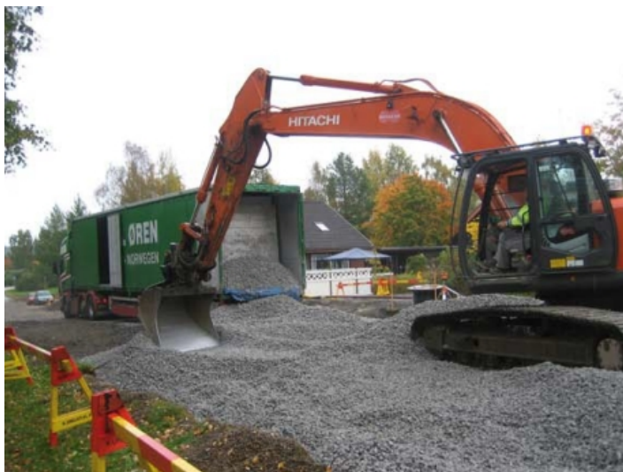
Kuva 5. Vaahtolasimurskeen kuljetuskalusto ja levitys tela-alustaisella kaivukoneella (Uusioaines Oy 2012)
