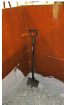
Kuva 26. Tiivistyskoe näytteen pohjakerroksen rakentaminen (Emilia Köyljärvi 2013)
