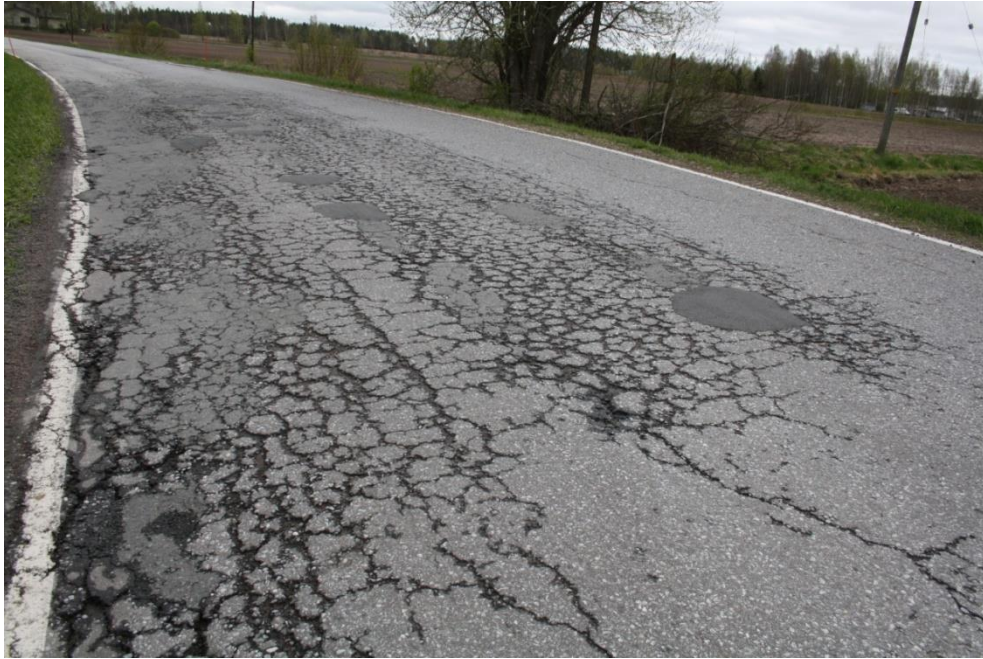
Kuva 3.10 Verkkohalkeiluun edennyttä väsymishalkeilua (Elina Lätti 2015)
