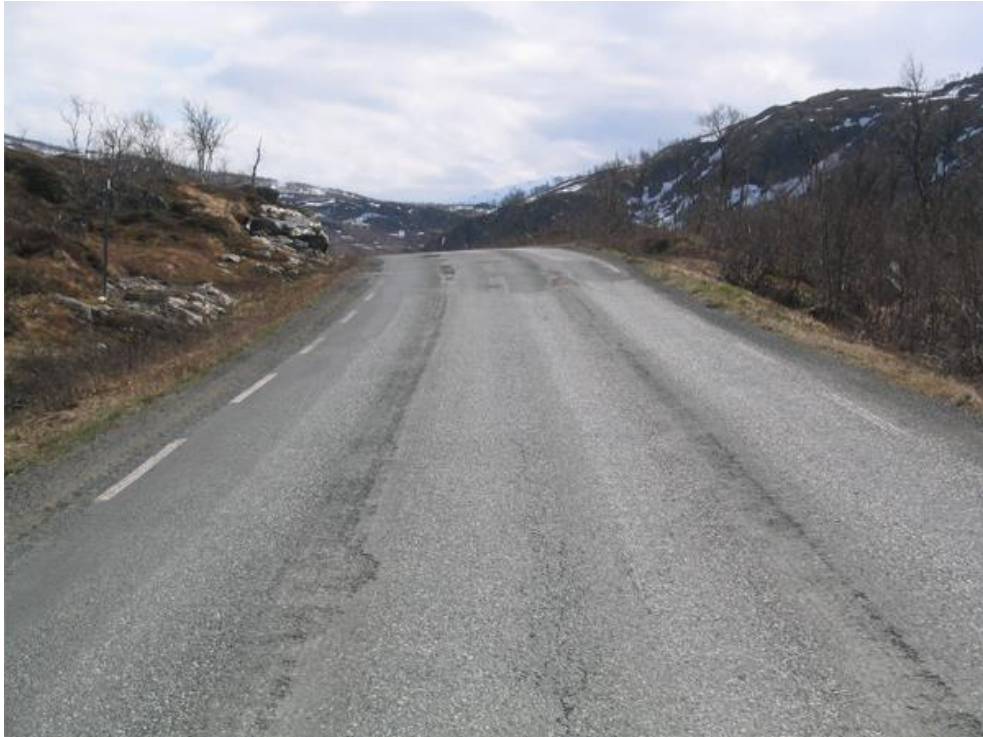
Kuva 3.14 Sitomattomien kerrosten deformaatiosta aiheutuvaa urautumista ( Roadex e-Learning )
