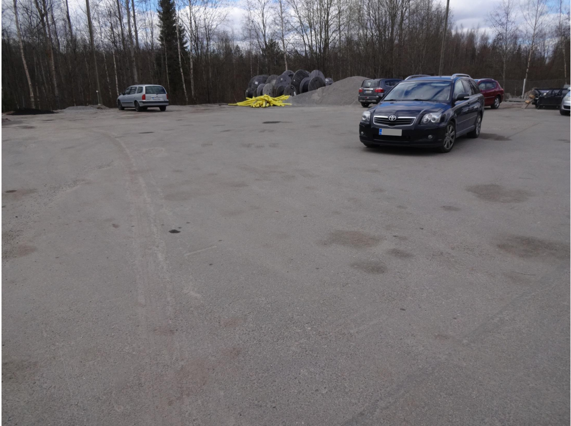
Kuva 28. Koekohteen 3 bitumikaterouhetta sisältävä kulutuskerros.
