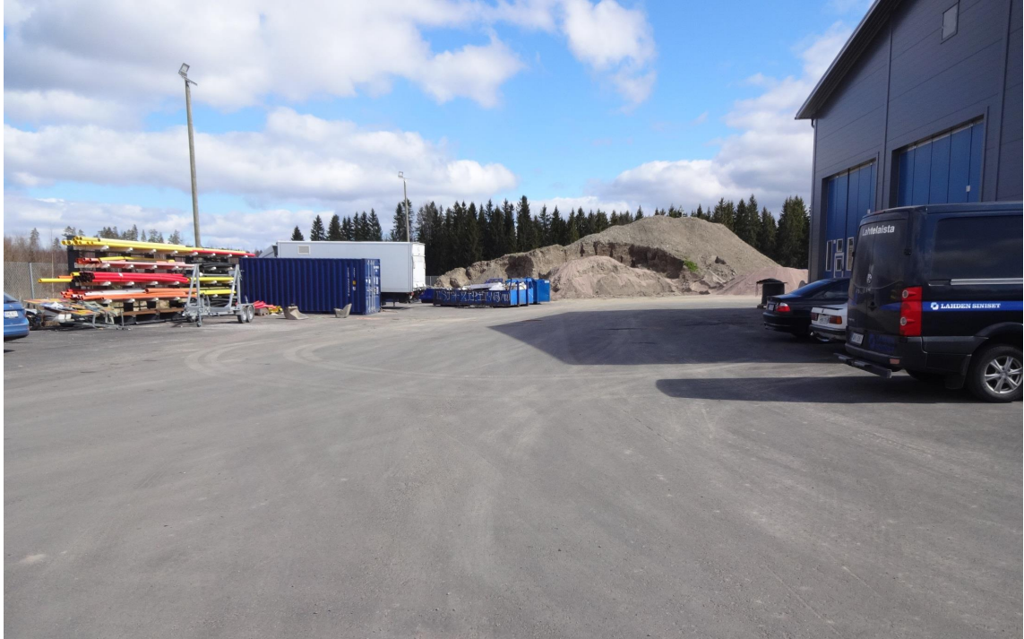
Kuva 27. Koekohteen 2 yleisilme hallin päädyistä, jossa bitumikaterouhetta sekä kulutettua rakennekerroksessa.
