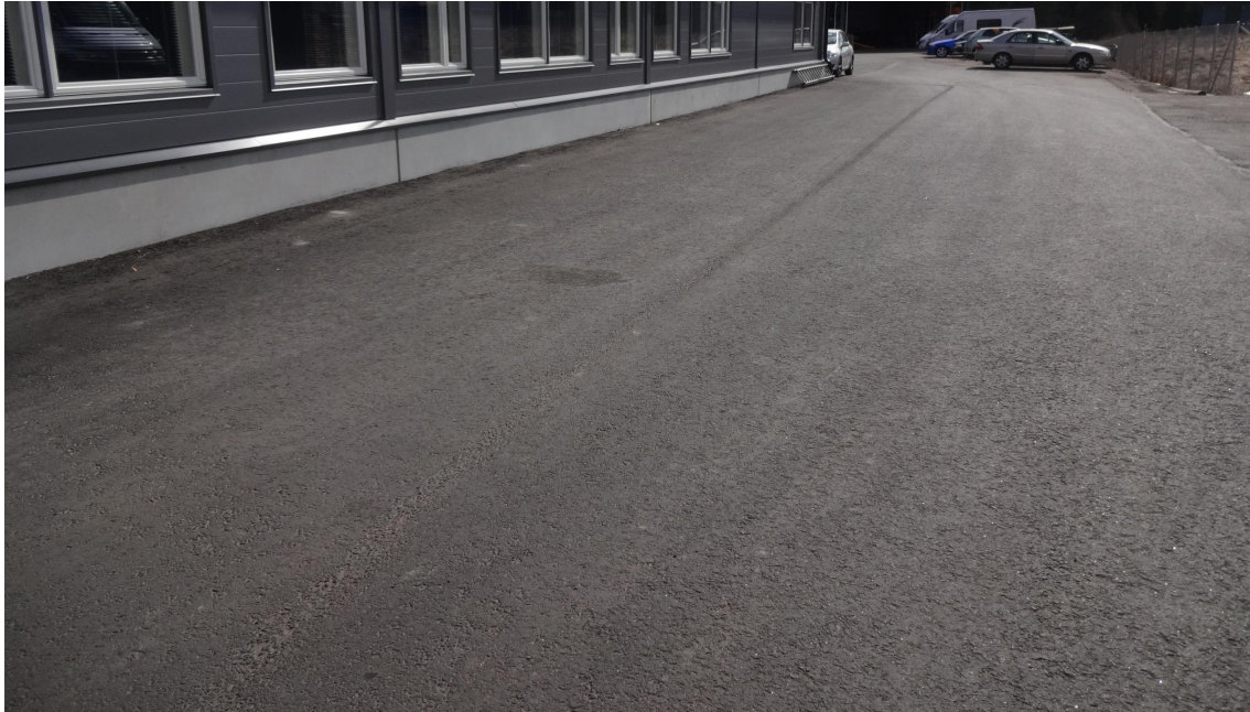
Kuva 46. Koekohteen 2 yleisilme hallin sivusta, jossa bitumikaterouhetta vain kulutuskerroksessa.
