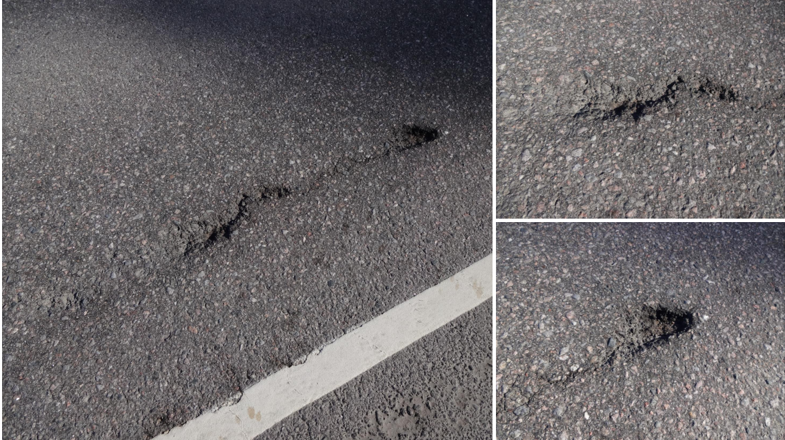
Kuva 44. Koekohteessa 1 RAS-päällysteessä havaittu massan lajittuneisuudesta johtuva päällysteen purkautuminen.
