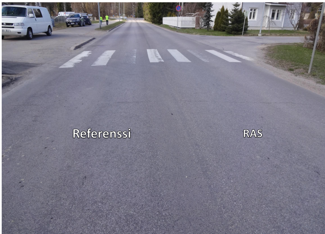
Kuva 51. Koekohteessa 7 havaittu koko kadun levyinen halkeama.
