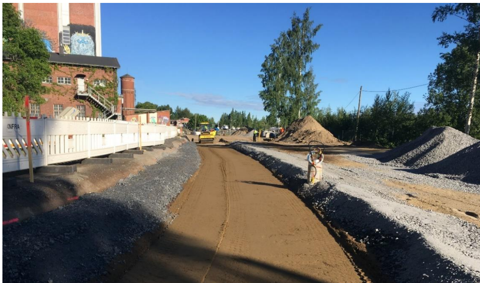
Kuva 4 Hiedanrannan kevyen liikenteen väylän rakennustyöt käynnissä vuonna 2018. Kuva: Ilari Harju.
