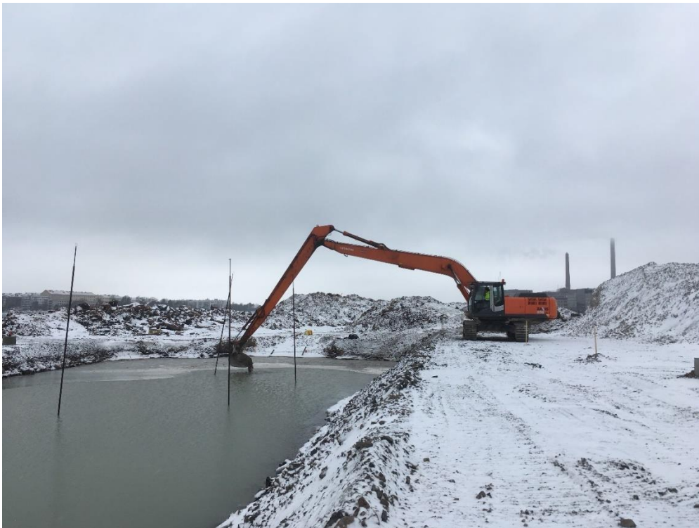
Kuva 16. Betonimurskeen # 0/90 täyttötöyö käynnissä koealueella 1 (Kuva: Anttila 7.3.2019).
