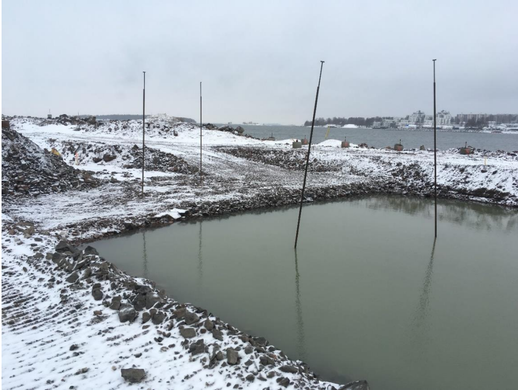
Kuva 15. Louhetäyttöalueen pinta ensimmäisellä täyttötasolla +0,9...+1 (Kuva: Anttila 7.3.2019).
