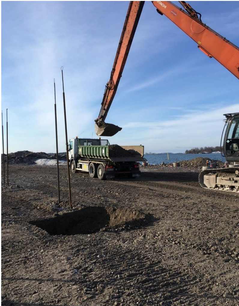
Kuva 22. Koekuopan kaivu ja materiaalin punnitus (Kuva: Anttila 15.3.2019).
