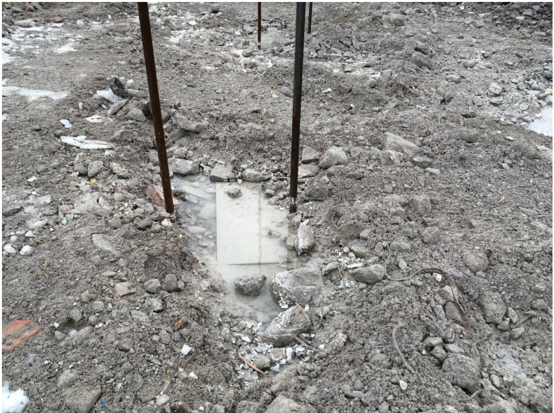
Kuva 17. Tasolle +0,9...+1 asennettu painumalevy sekä kaivannon pohjalle asennetun painumalevyn tanko koealueella 3 (BeM # 0/300) (Kuva: Anttila 15.3.2019).
