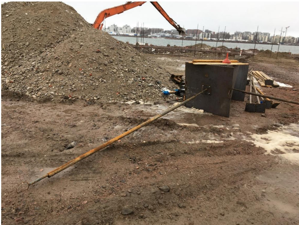
Kuva 7. Painumalevy ennen kaivantoon asentamista (Kuva: Anttila 15.3.2019).
