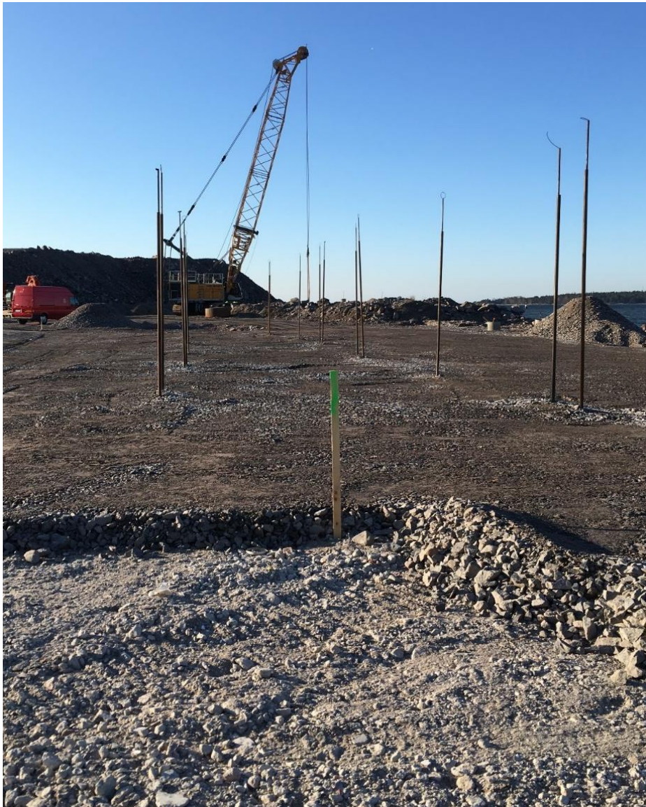
Kuva 23. Koealue ennen pudotustiivistystä (Kuva: Anttila 3.4.2019).
