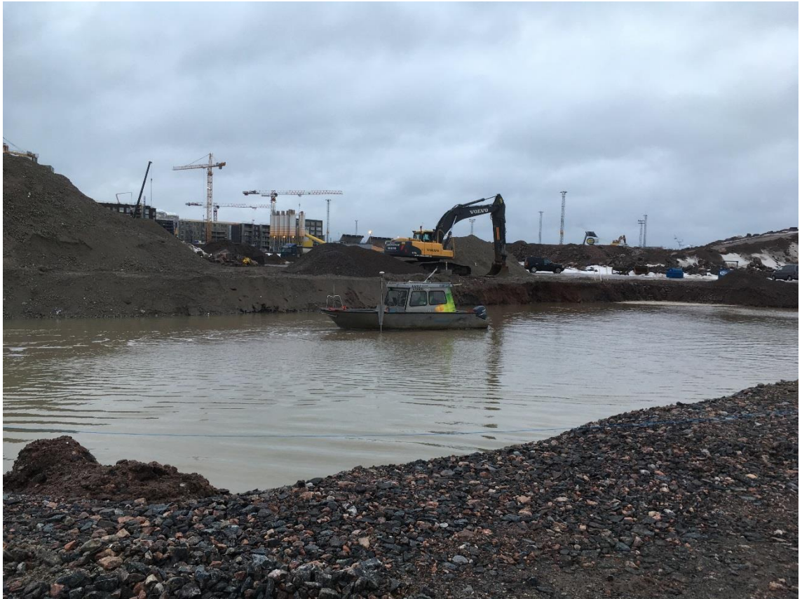
Kuva 13. Kaivannon pohjan monikeilaluotaus. (Kuva: Anttila 20.2.2019).
