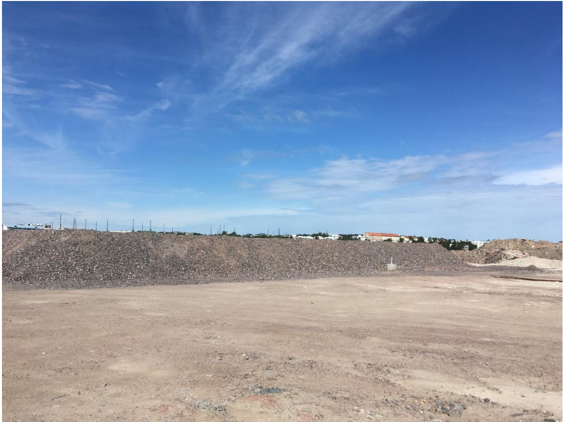
Kuva 30. Esikuormituspenger koetiivistysalueen päällä (Kuva: Anttila 12.6.2019).
