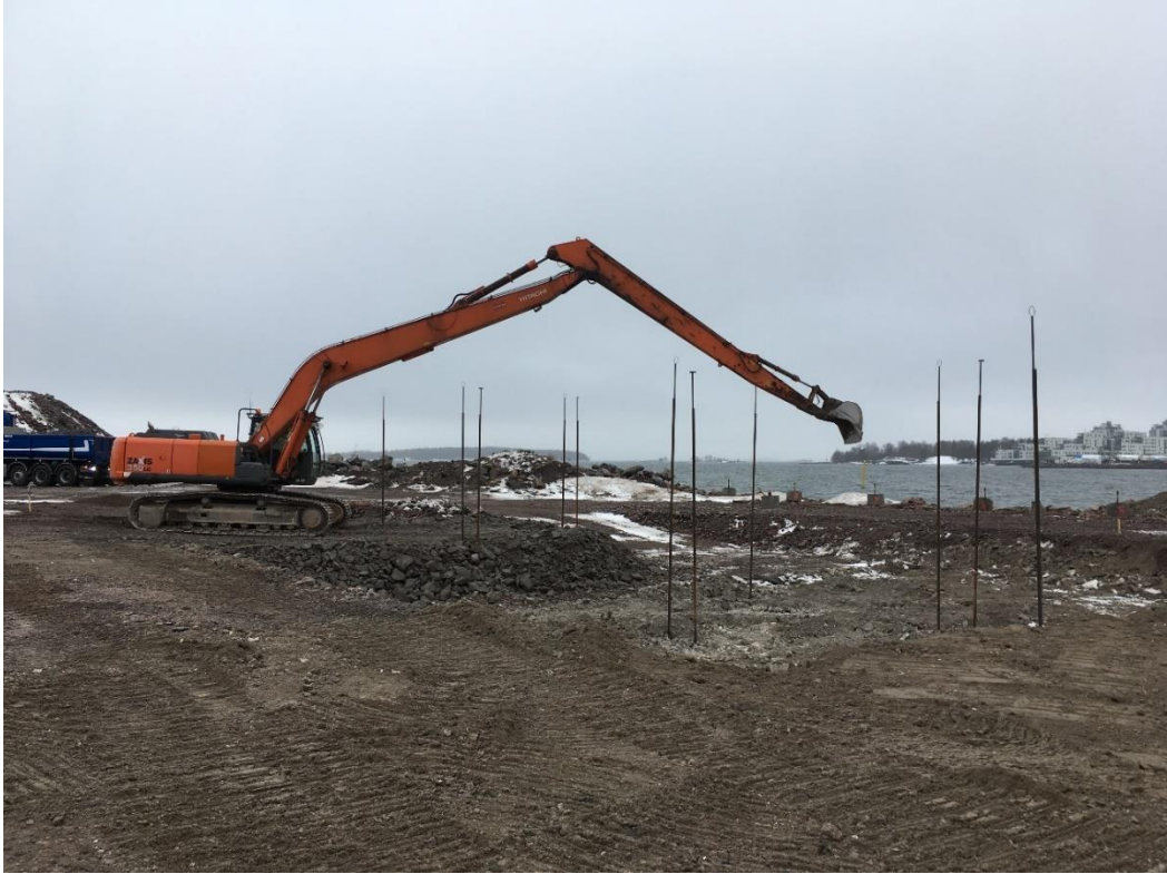
Kuva 20. Kaivannon täyttö lopulliseen täyttötasoon (Kuva: Anttila 15.3.2019).
