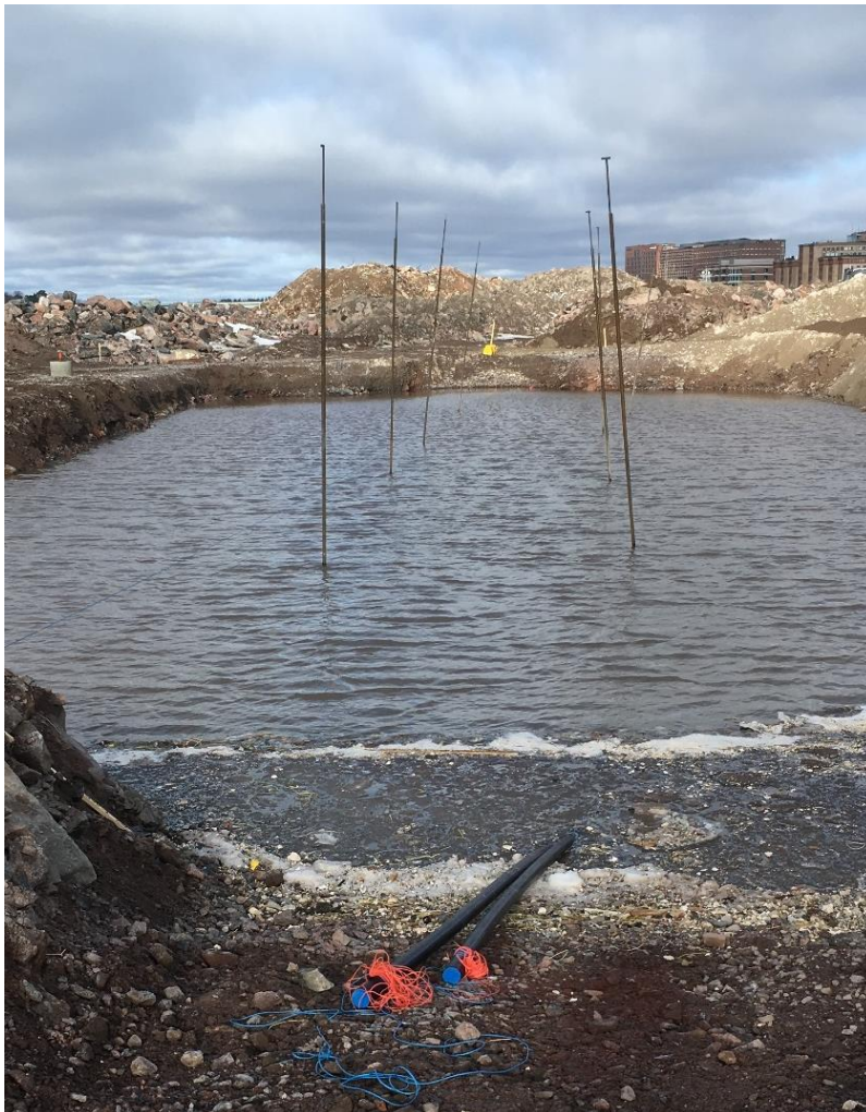
Kuva 14. Koerakenteen pohjalle asennettujen tangolliset painumalevyjen tangot sekä painumaletkujen päät (Kuva: Anttila 26.2.2019).
