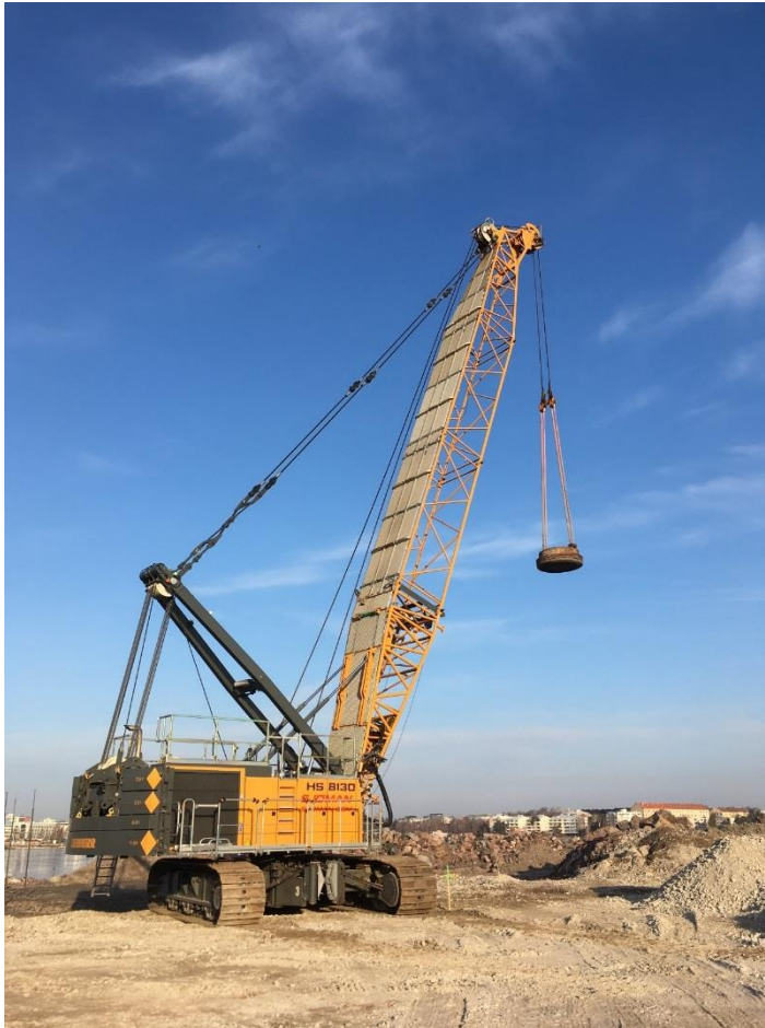
Kuva 1. Ristikkopuominosturi Tritonipuiston koekentällä (Kuva: Anttila 5.4.2019).
