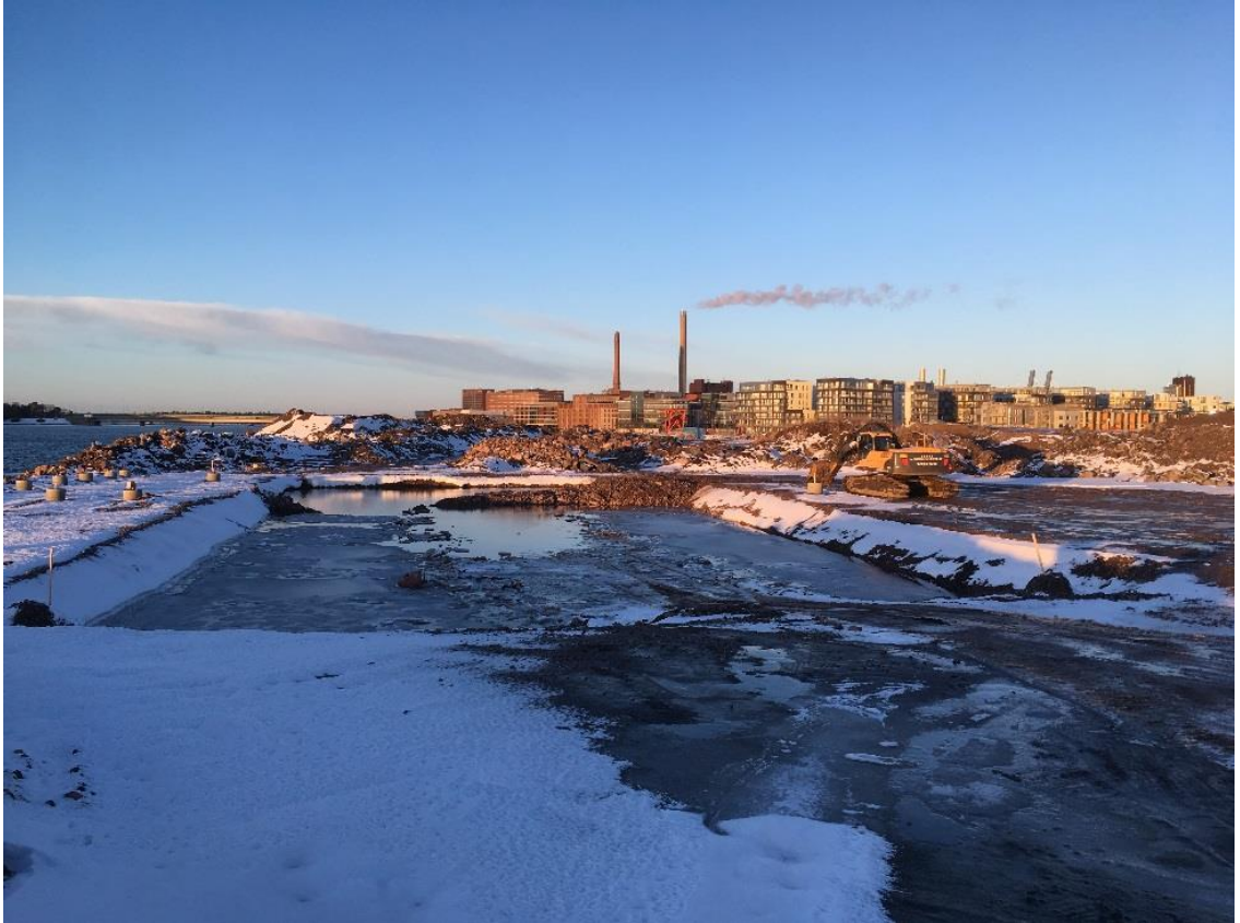
Kuva 12. Koerakenteen altaan kaivanto (Kuva: Anttila 11.1.2019).
