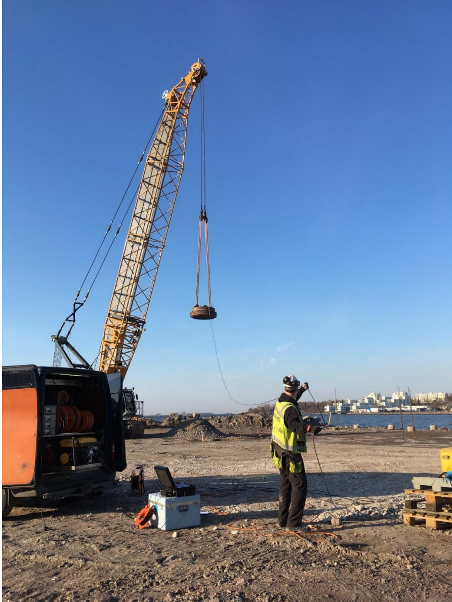
Kuva 26. Hidastuvuusmittauksia pudotustiivistystyön yhteydessä (Kuva: Anttila 4.4.2019).
