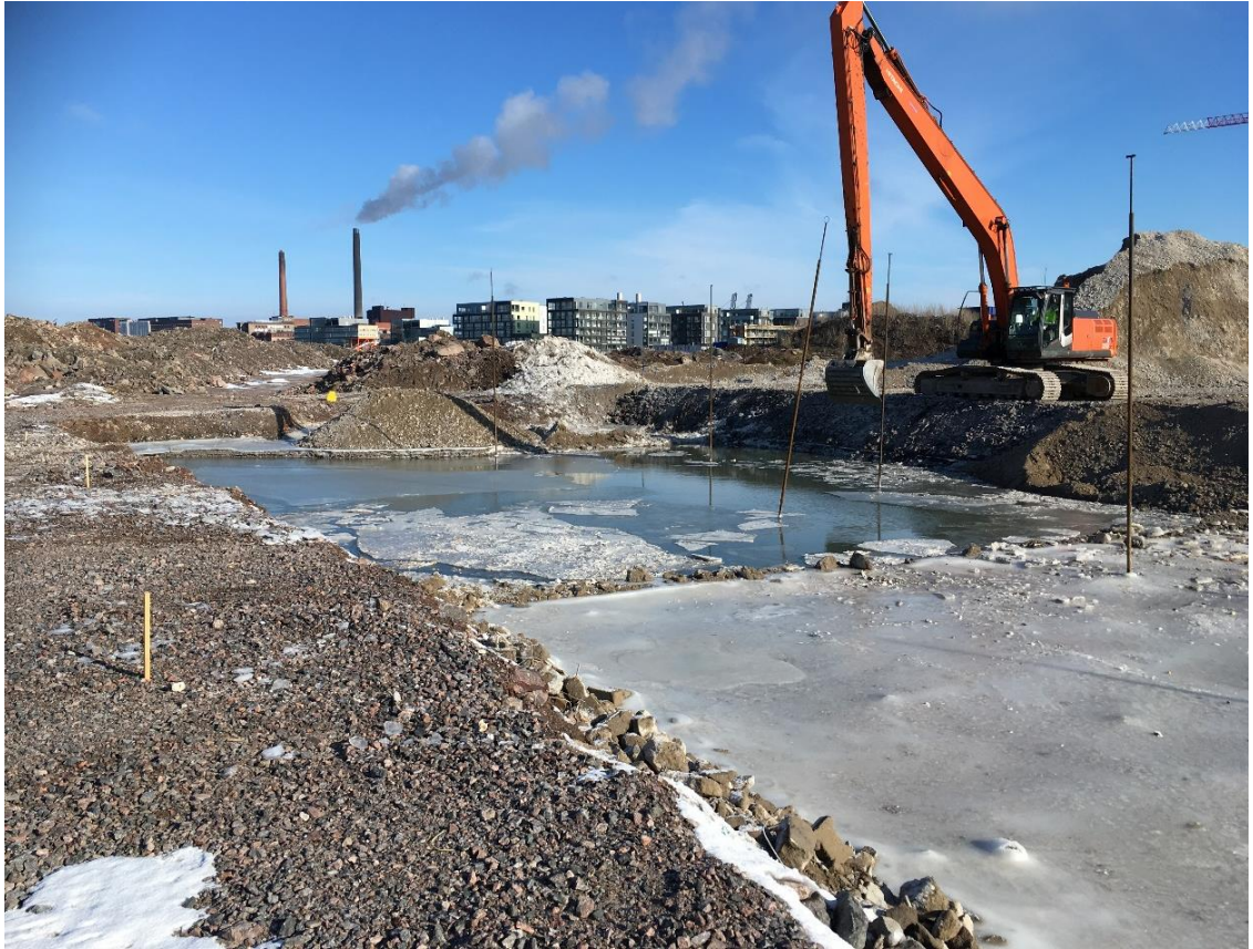
Kuva 18. Jään poistoa koerakenteen kaivannosta (Kuva: Anttila 12.3.2019).
