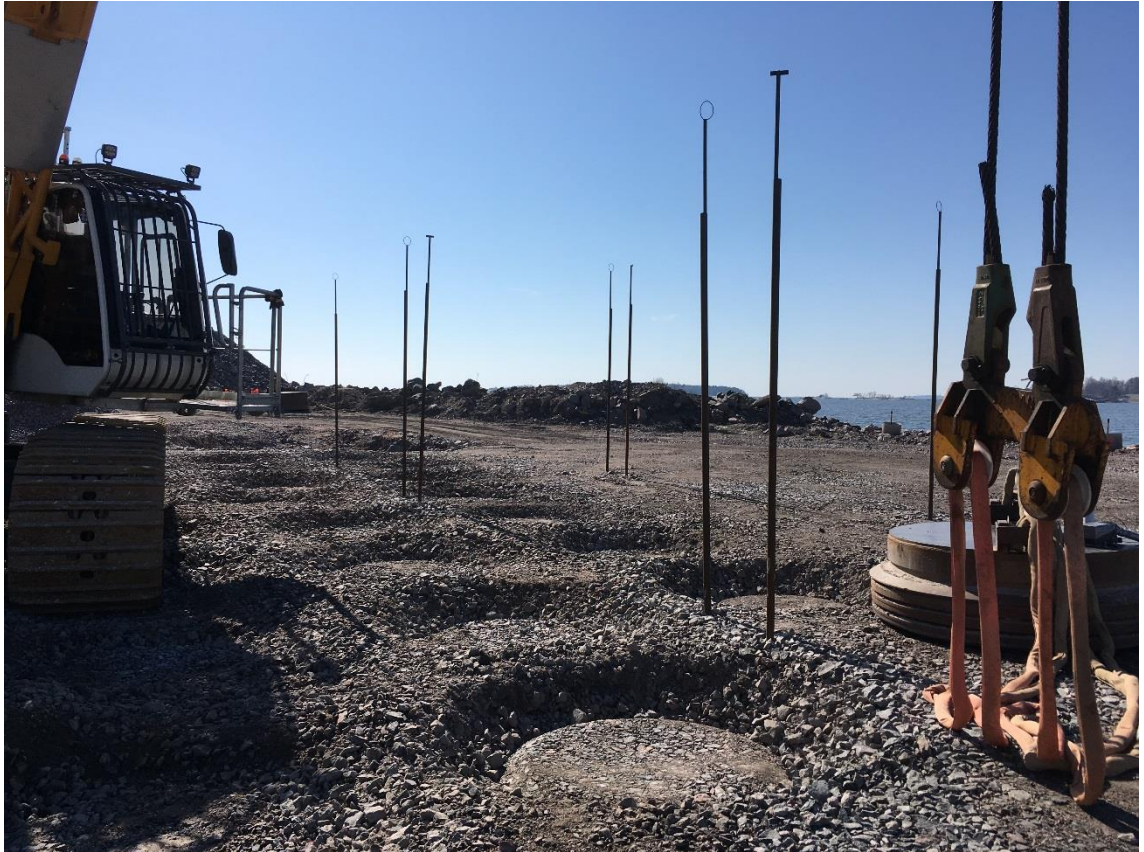
Kuva 24. Pudotusjätkäleen aiheuttamia painumia täytön pinnassa ensimmäisen pudotuskierroksen jälkeen (Kuva: Anttila 4.4.2019).
