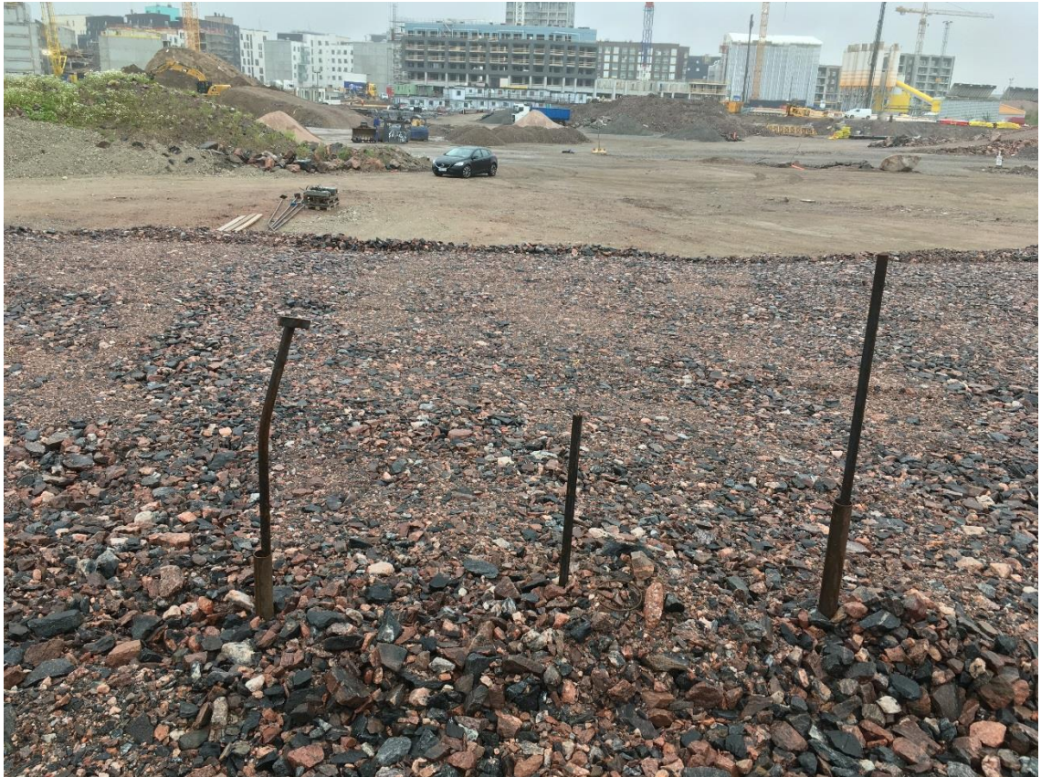
Kuva 31. Vääntynyt painumalevyyn tangon pää (Kuva: Anttila 27.6.2019).
