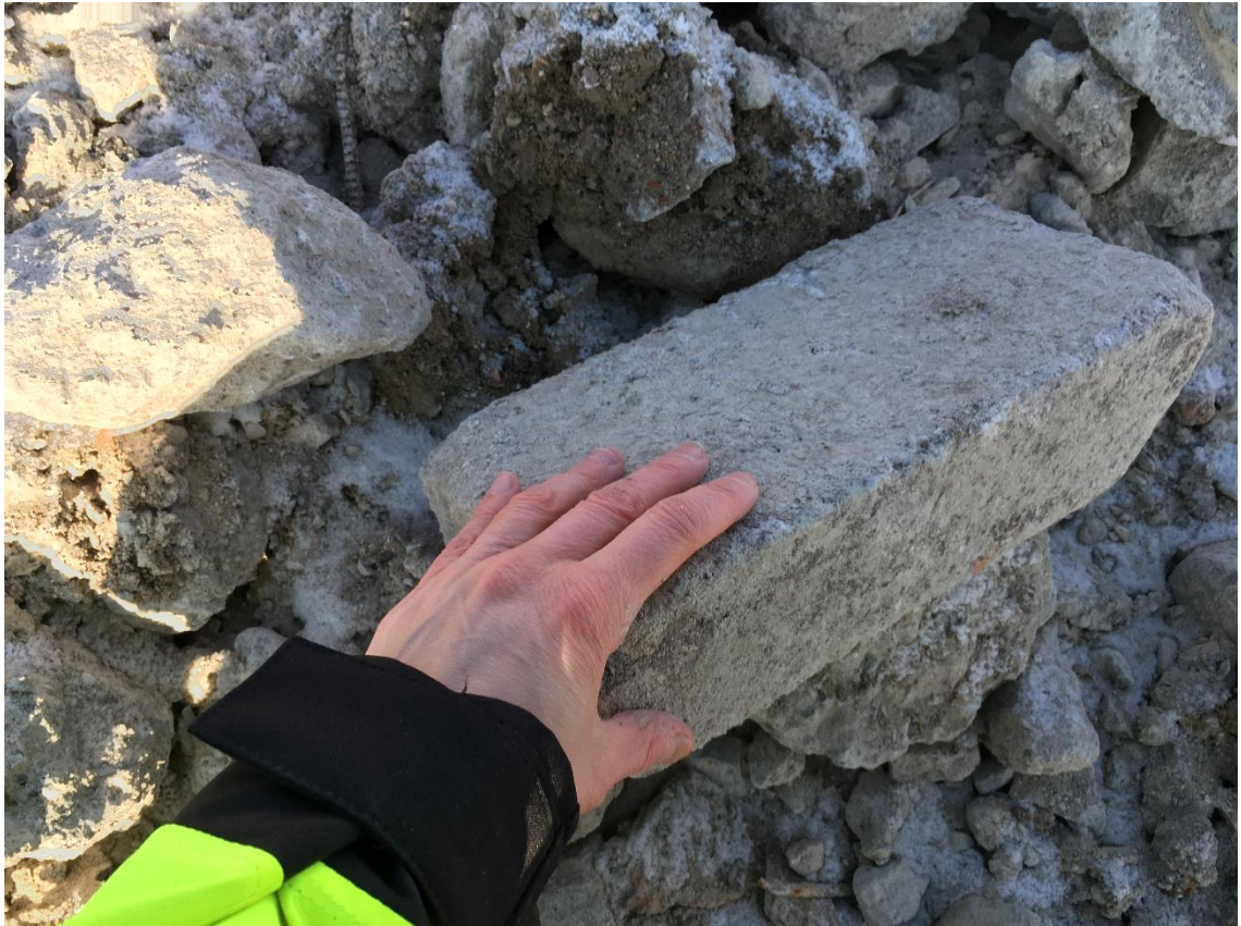
Kuva 28. Betonimurskeen # 0/300 seassa oleva tiili (Kuva: Anttila 12.3.2019).
