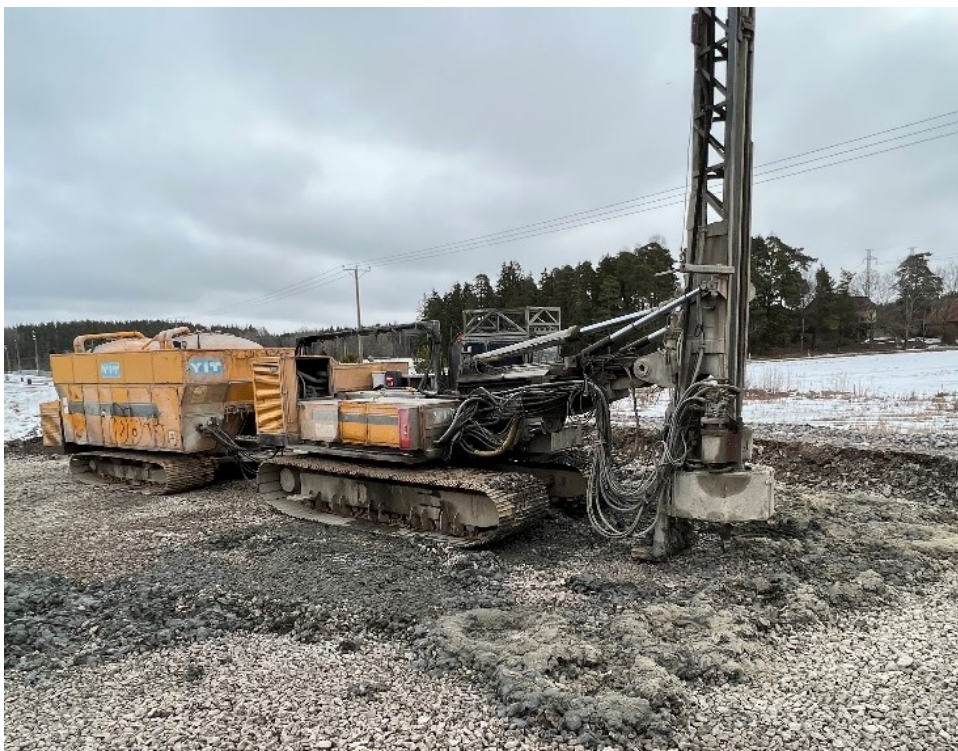
Kuva 1. Pilaristabilointikone Topinpuiston koestabilointikentällä (valokuva Onerva Oksman 9.3.2022).
