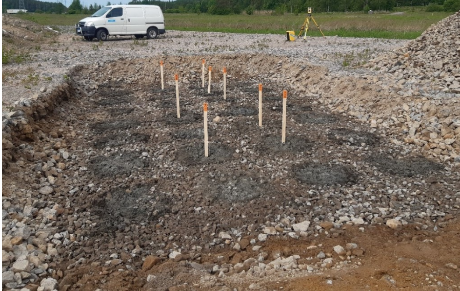
Kuva 2. Koestuksia varten esiin kaivetut ja merkatut pilareiden yläpää Topinpuistossa (Ramboll Oy).
