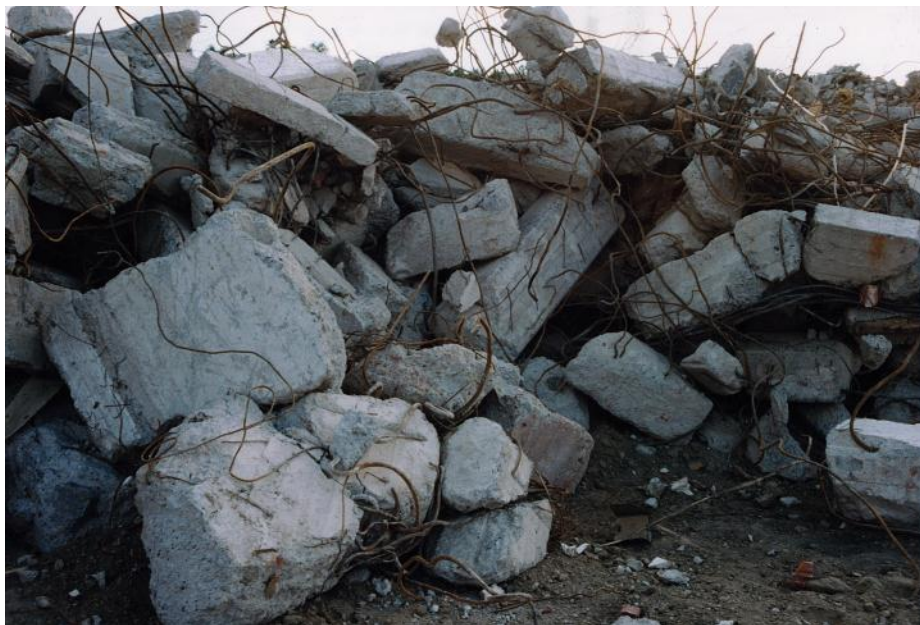
Betonijäte valikoivasta purusta
