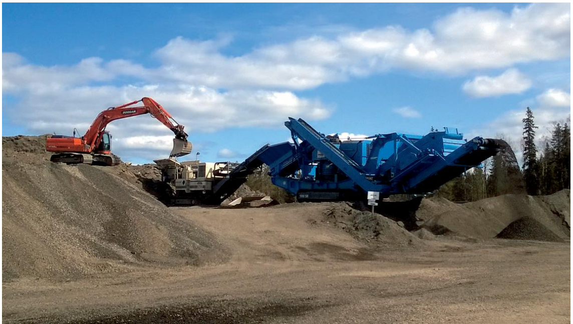
Kuva 4.4 Betonijätteen murskausta liikuteltavalla murskainlaitoksella jätteenkäsittelyalueella (Saarinen 2015).
