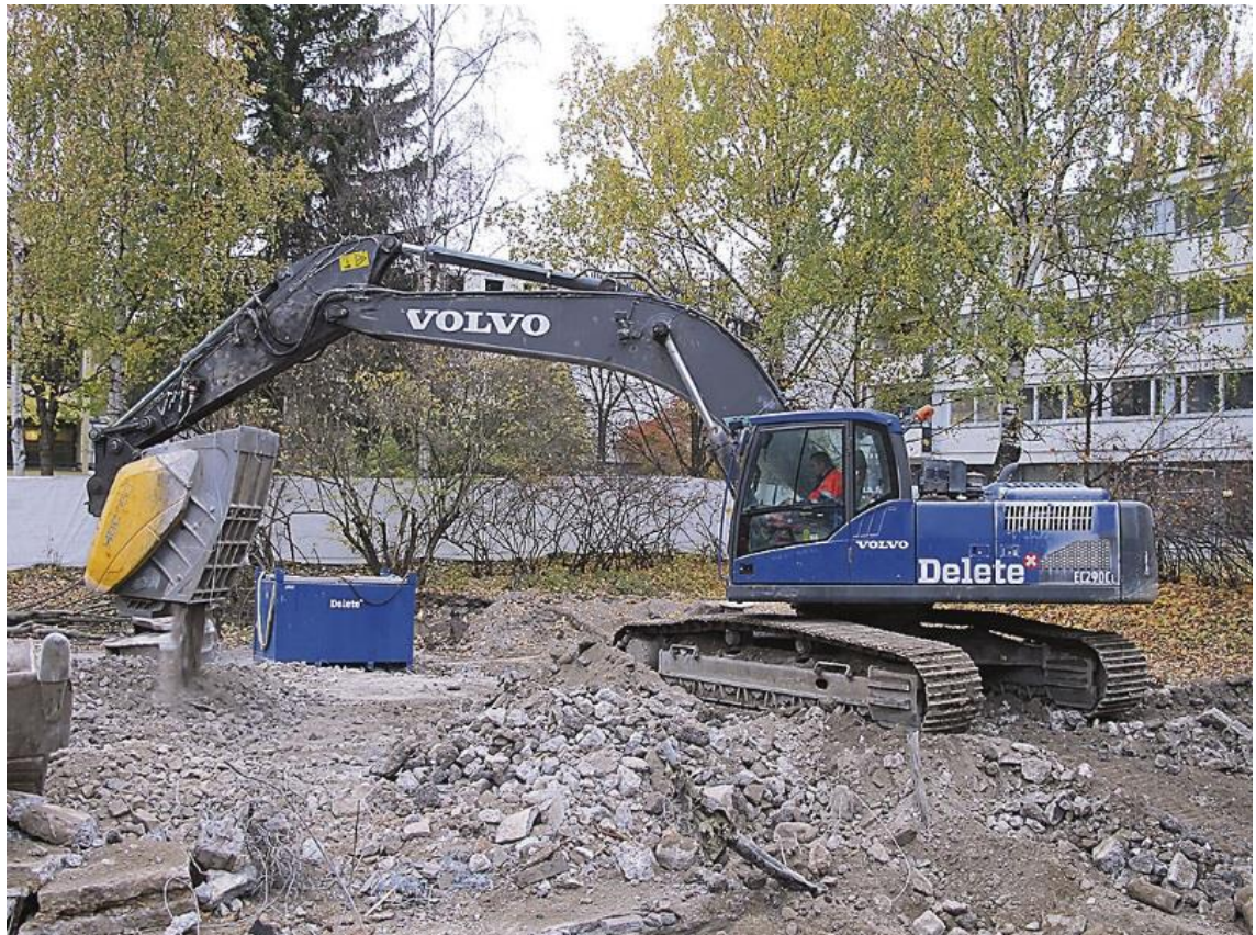
Kuva 4.5 Betonijätteen murskausta työmaalla kaivinkoneeseen kiinnitetyllä kauhamurskaimella (Konepörssi 2013).
