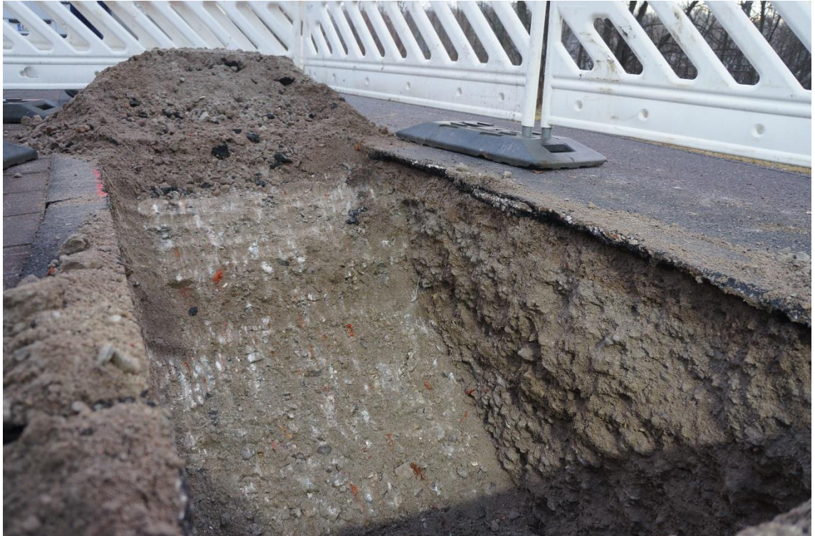
Kuva 5.8 Aukikaivettu betonimurskerakenne. Kuva: Taavi Dettenborn (Ramboll Finland Oy 2014).
