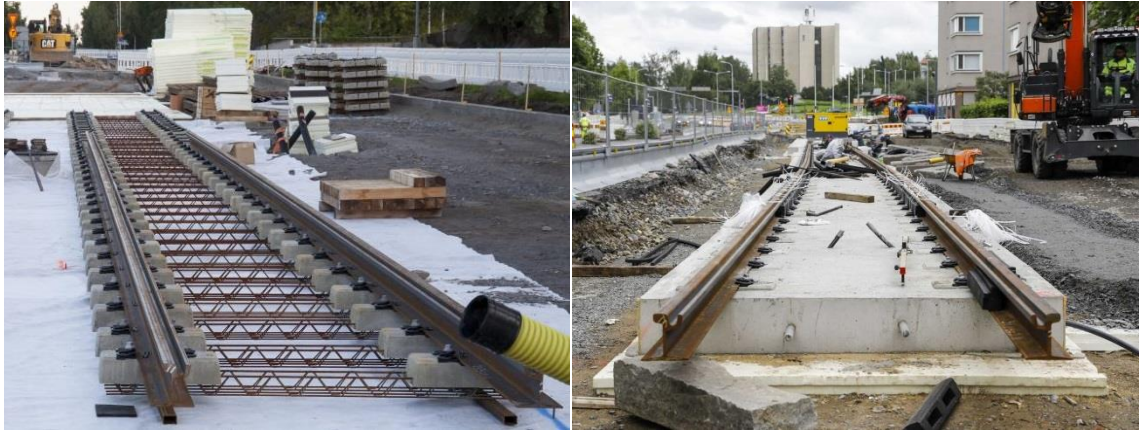
Kuva 2.14 Rheda-kiintoraidejärjestelmän asennusta Tampereella. Kuvat: Susanna Lyly (Raitiotieallianssi 2017a) ja Ossi Ahola (Aamulehti 2017).
