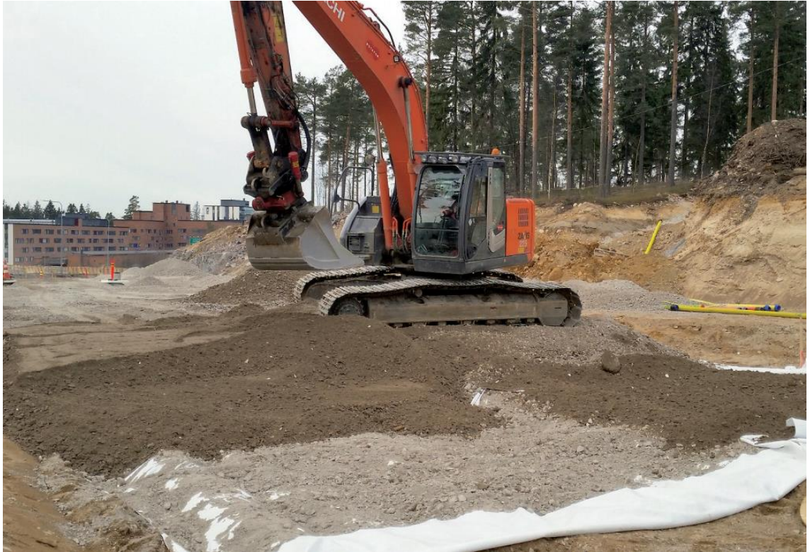
Kuva 5.7 Katurakentamista betonimurskeella. Kuva: Rudus Oy (Saarinen 2015).
