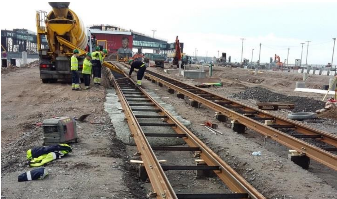
Kuva 2.12 Raitiotieradan rakentamista Helsingin Jätkäsaarella vuonna 2016 (Helsingin Satama Oy 2016).
