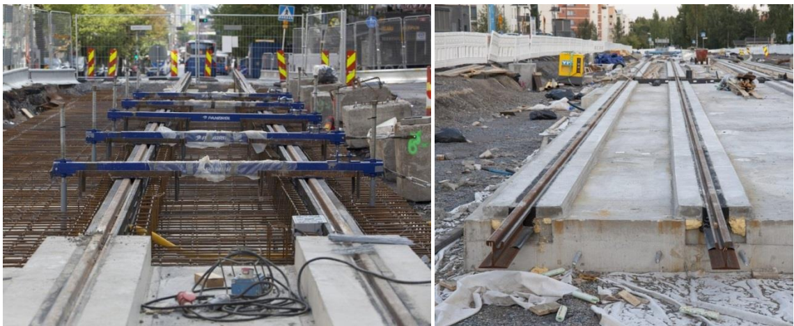
Kuva 2.15 Pandrol-kiintoraidejärjestelmän asennusta Tampereella. Kuvat: Susanna Lyly (Raitiotieallianssi 2017a).
