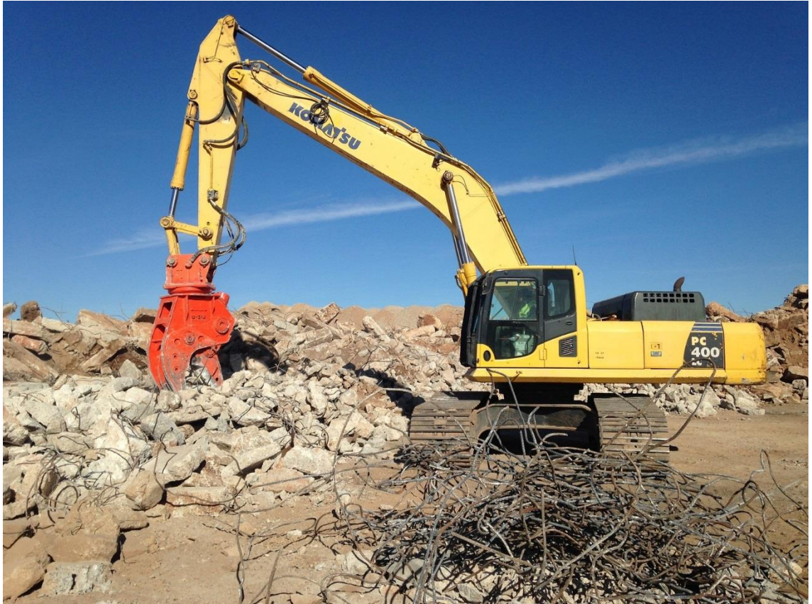
Kuva 4.2 Betonin pulverointia kaivinkoneeseen kiinnitetyllä lisälaitteella. Etualalla betonijätteestä eroteltuja raudoitteita. (NPK Construction Equipment, Inc. 2018)
