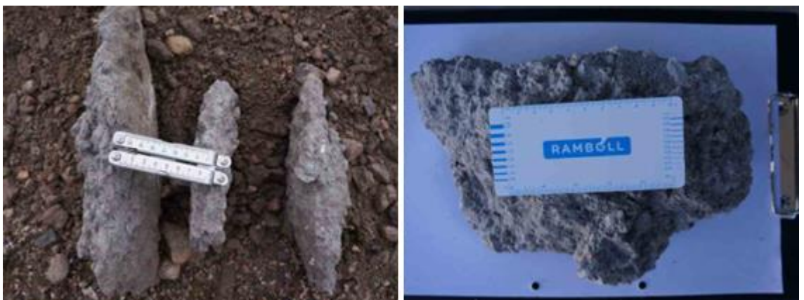
Kuva 5.9 Betonimurskerakenteesta aukikaivettua betonimurskettä. Kokkareet ovat I-luokan betonimurskeesta erittäin raskaan kuormituksen alla muodostuneita. Kuvat: Taavi Dettenborn (Ramboll Finland Oy 2014).
