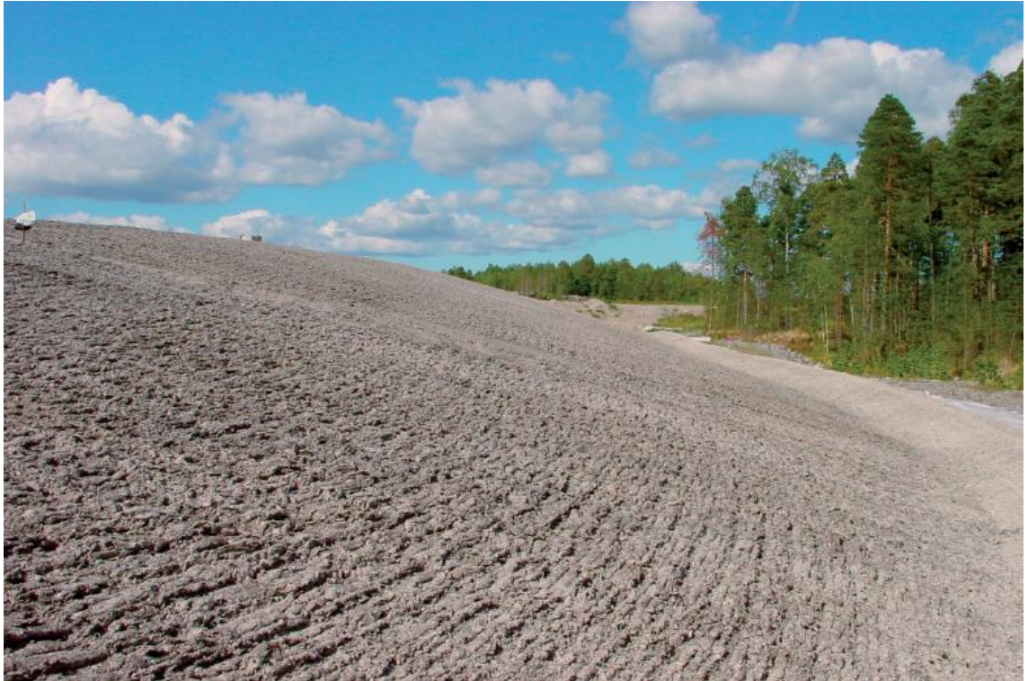
Kuva 26. Kuitusavesta rakennettu pintarakenteen mineraalinen tiivistyskerros (RT 38715)
