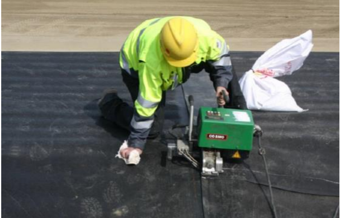
Kuva 9. Kuumakiilahitsaus (Ölly- ja biopolttoaineala ry 2016, s.29)
