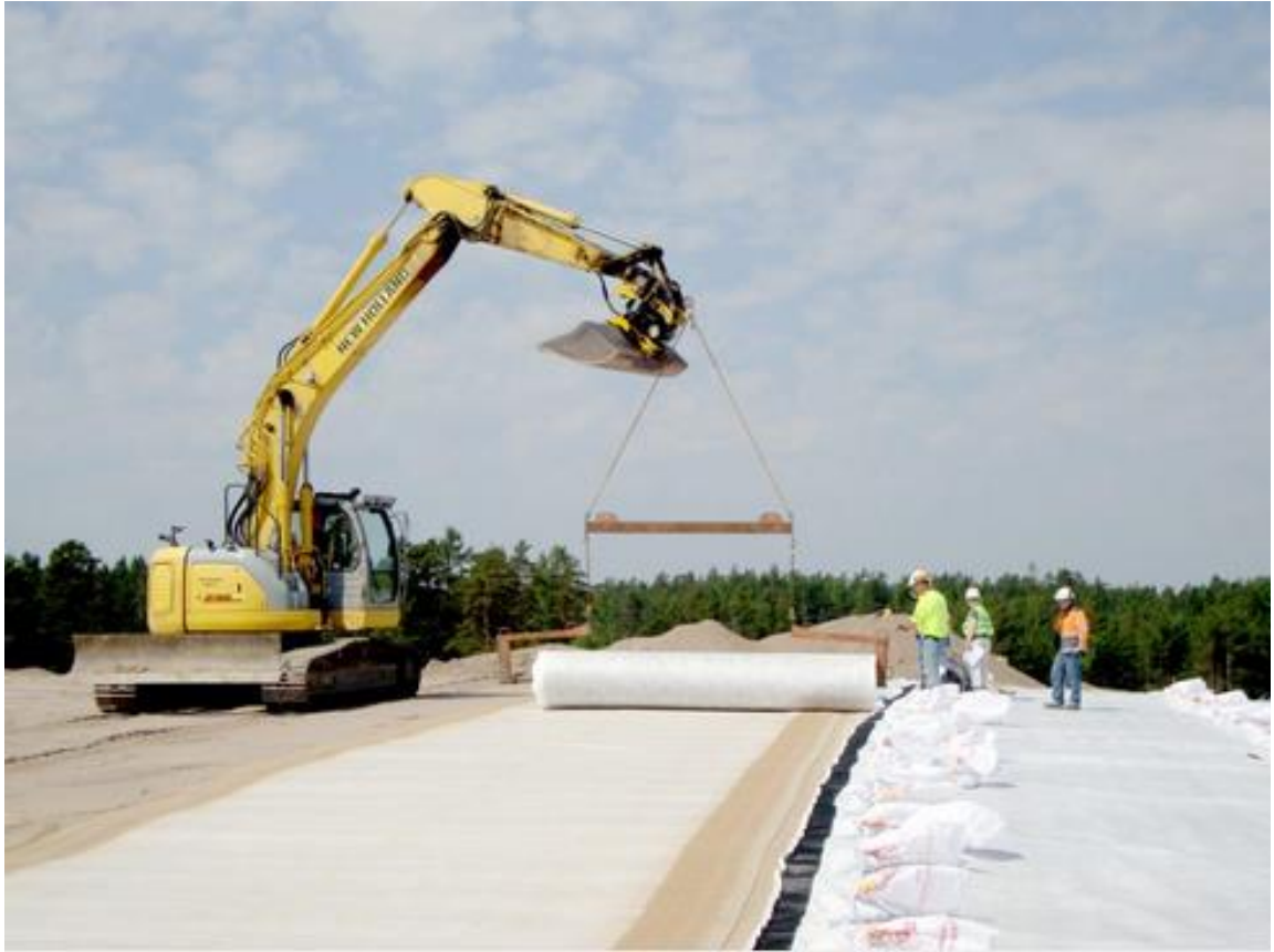
Kuva 16. Bentoniittimaton asennusta (Geosynt Oy 2018)
