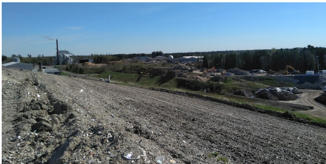
Kuva 40. Rakennus- ja purkujätteen rejekteillä muotoiltu esipeittokerros, kuva Kiimassuon jätekeskukselta vuodelta 2018
