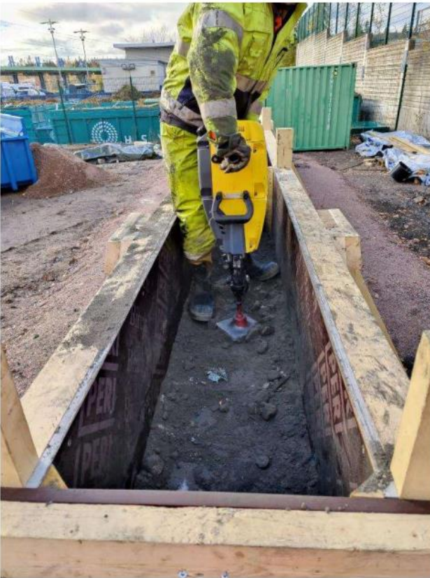
Kuva 7.5. Massan tiivistäminen muotin sisällä Atlas Copcon 25 kg:n poravasaralla. (18.10.2021)
