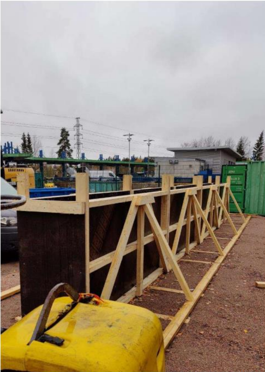
Kuva 7.2. Koerakentamista varten tehty muotti. (15.10.2021)
