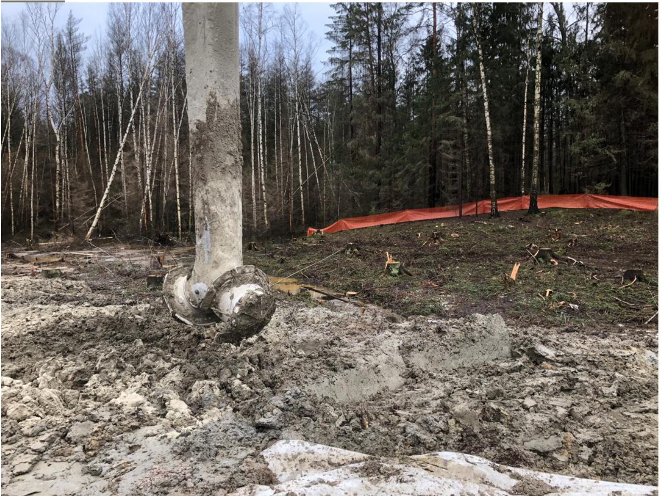
Valokuva 5. Saven massastabilointia vallin koilliskulmassa.
