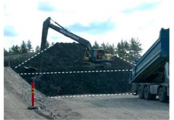
Kuva 4. Suunnitelmapoikkileikkaus sekä vallin rakentamisesta massastabiloidulla ruoppausmassalla.
