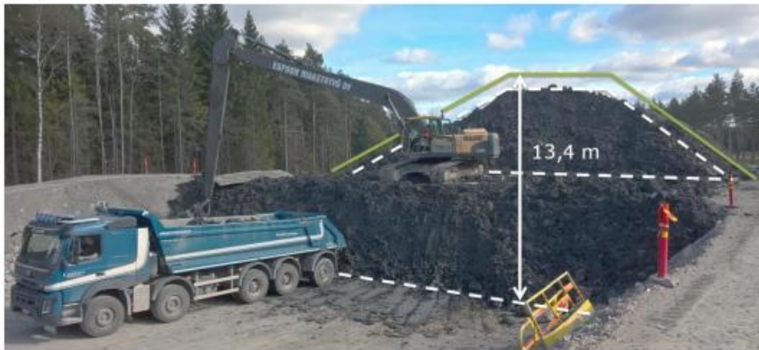
Kuva 4. Suunnitelmapoikkileikkaus sekä vallin rakentamisesta massastabiloidulla ruoppausmassalla.
