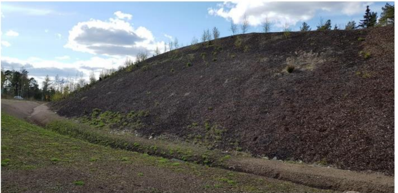
Kuva 10. Valmis meluvalli. Kuva vallin itäpäästä vallin eteläpuolelta.
