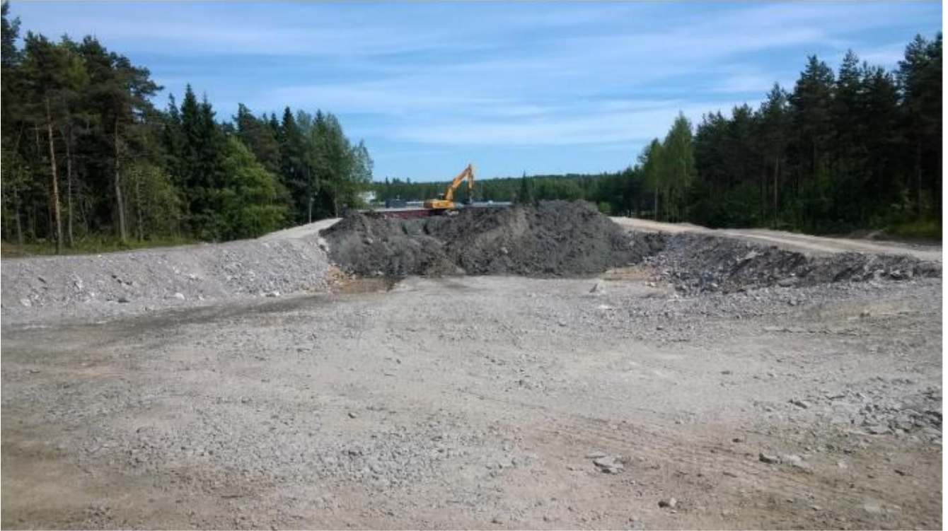
Kuva 4. Stabiloidun sedimentin läjitystä tukipenkereiden väliin 7.6.2016, vallin pohjalle levitetty betonimursketta
