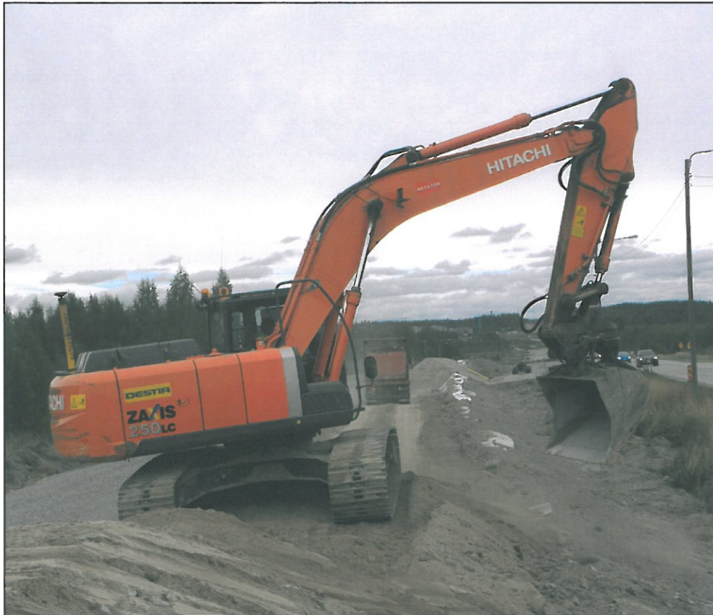
Kuva 9. Meluvallin muotoilu onnistui loistavasti kaivinkoneen avulla. Kuvassa on valmis lentotuhkakerros, johon tuli vielä 50 cm:n suojamaakerros.
