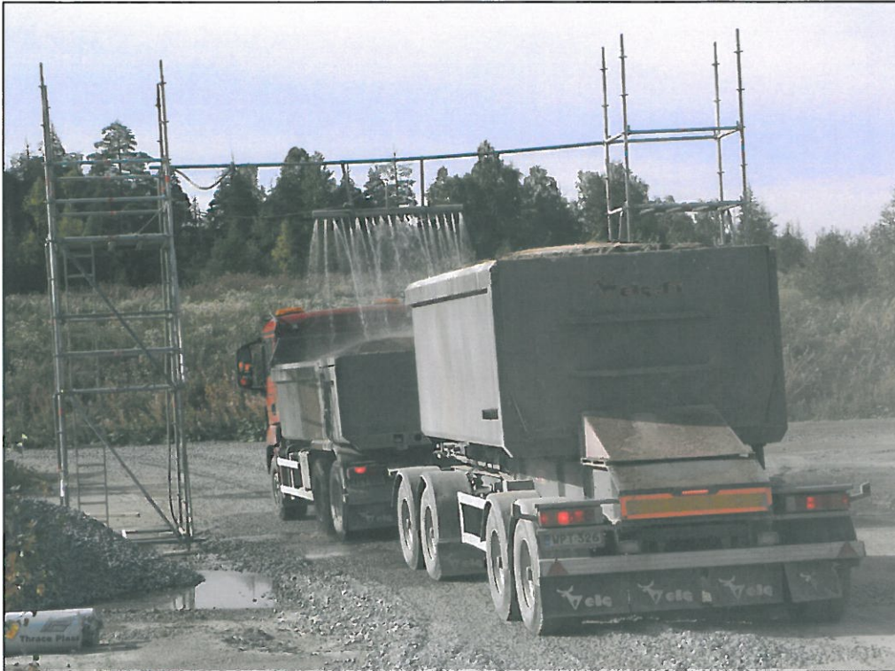
Kuva 7. Tuhkan kastelu automaattisen kastelujärjestelmän avulla. Kastelupisteessä on murskepohja, jonka ansiosta lentotuhkaa ei kulkeutunut pois kaatopaikka-alueelta.
