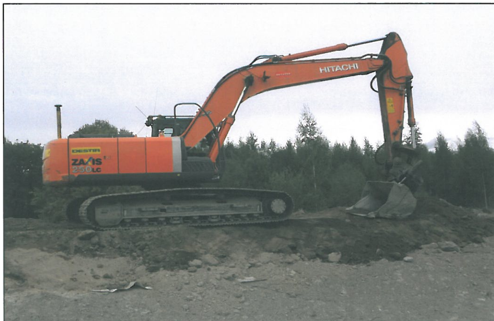
Kuva 10. Suojamaakerroksen, moreenin, levitys lehtotuhkarakenteen päälle.
