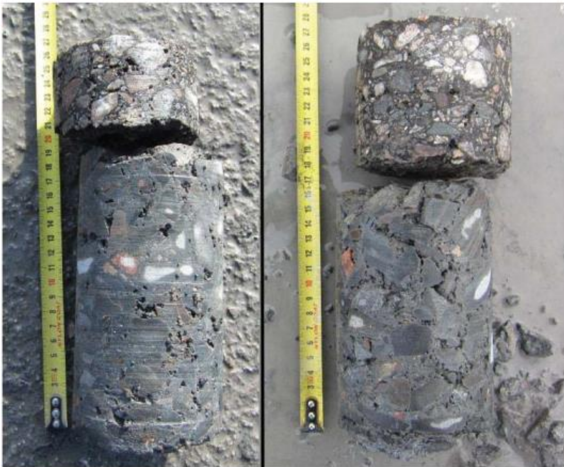
Kuva 6. Näytteet stabiloidusta kivimurskeesta, 250 mm paksu kerros. (T. Tarkkio, 2017. "Long-term functionality of fly ash in road and field structures")
