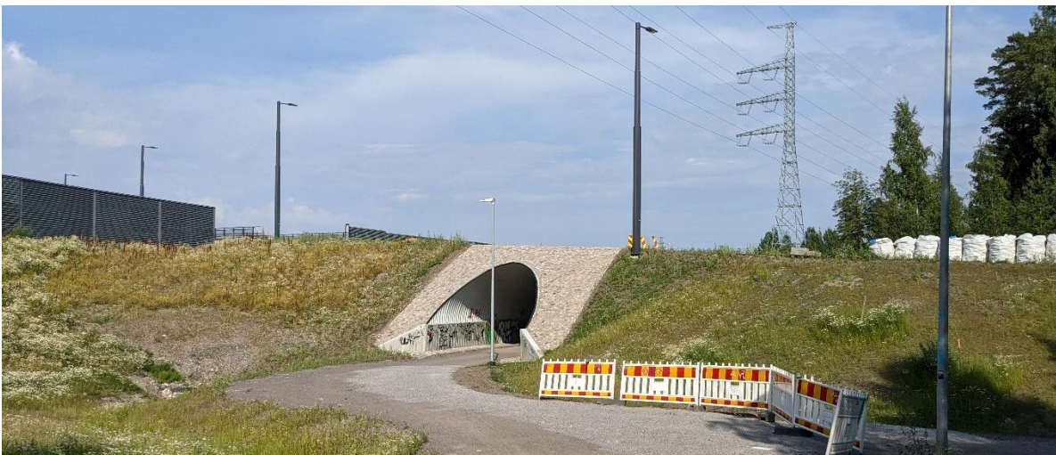
Kuva 2. Impilahdensillan eteläinen tulopenger kesällä 2021.
