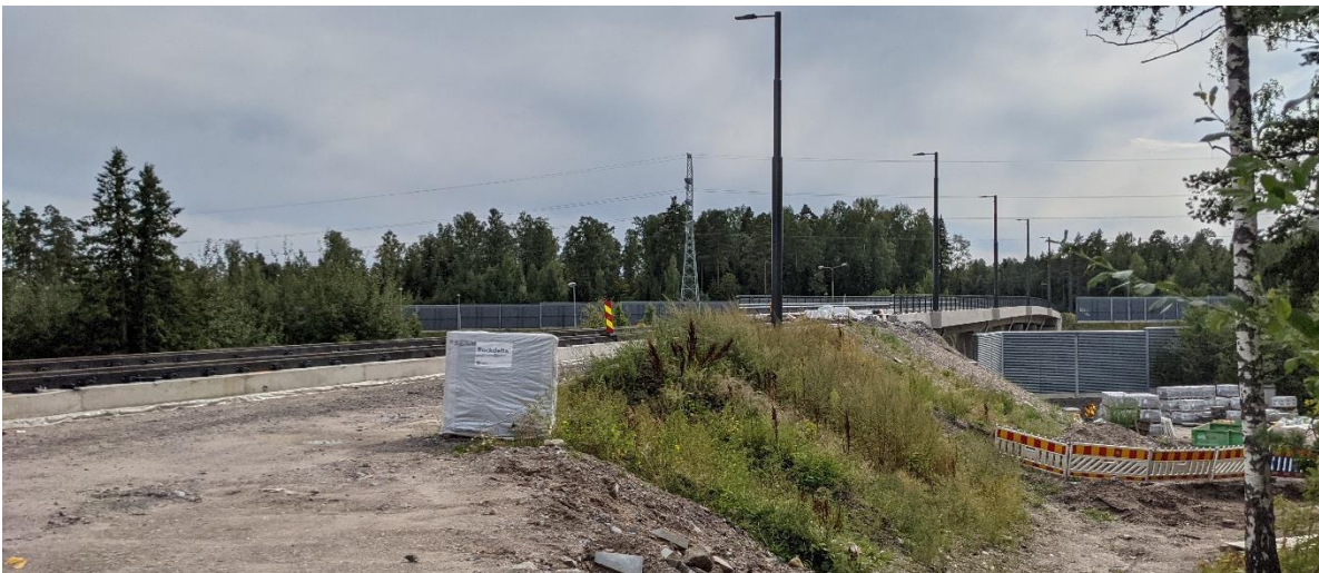
Kuva 3. Impilahdensillan pohjoinen tulopenger kesällä 2021.
