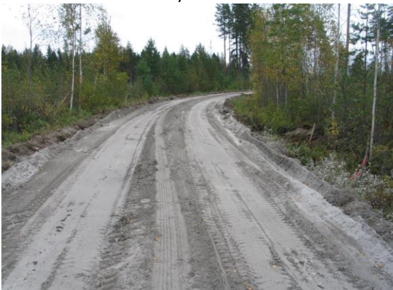
Kuva 5. Tiivistetty tuhkerakros.
