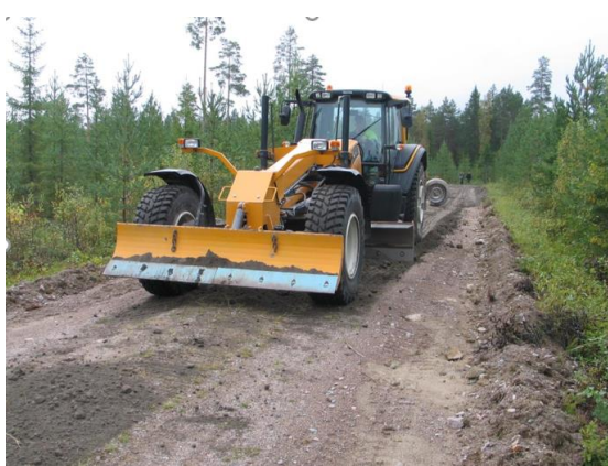
Kuva 2. Pohjan muotoilu kaukaloksi.
