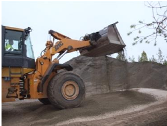
Kuva 6. Murskeen levitys tuhkerakrosen päälle.
