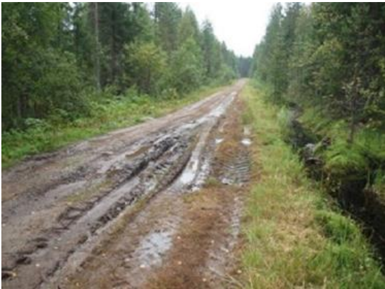
Kuva 1. Tie ennen parannusta.
