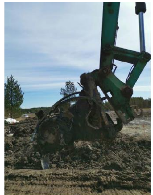
Kuva 8. Matalahti. Sideaineiden lisääminen koeruuuihin ja sekoitus jysijällä (massastabilointi, GTK 2021).
