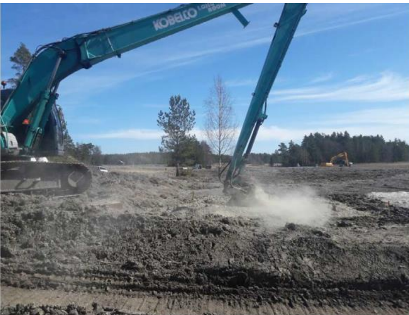
Kuva 8. Matalahti. Sideaineiden lisääminen koeruuuihin ja sekoitus jysijällä (massastabilointi, GTK 2021).
