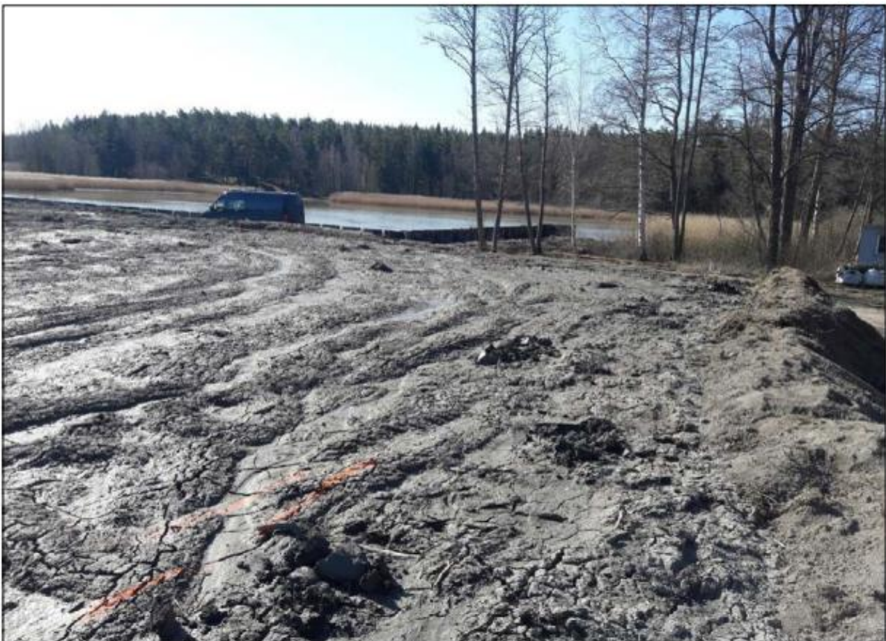
Kuva 6. Matalahti. Ruoppausmassaa ennen sideaineen levitystä (GTK 2021).
