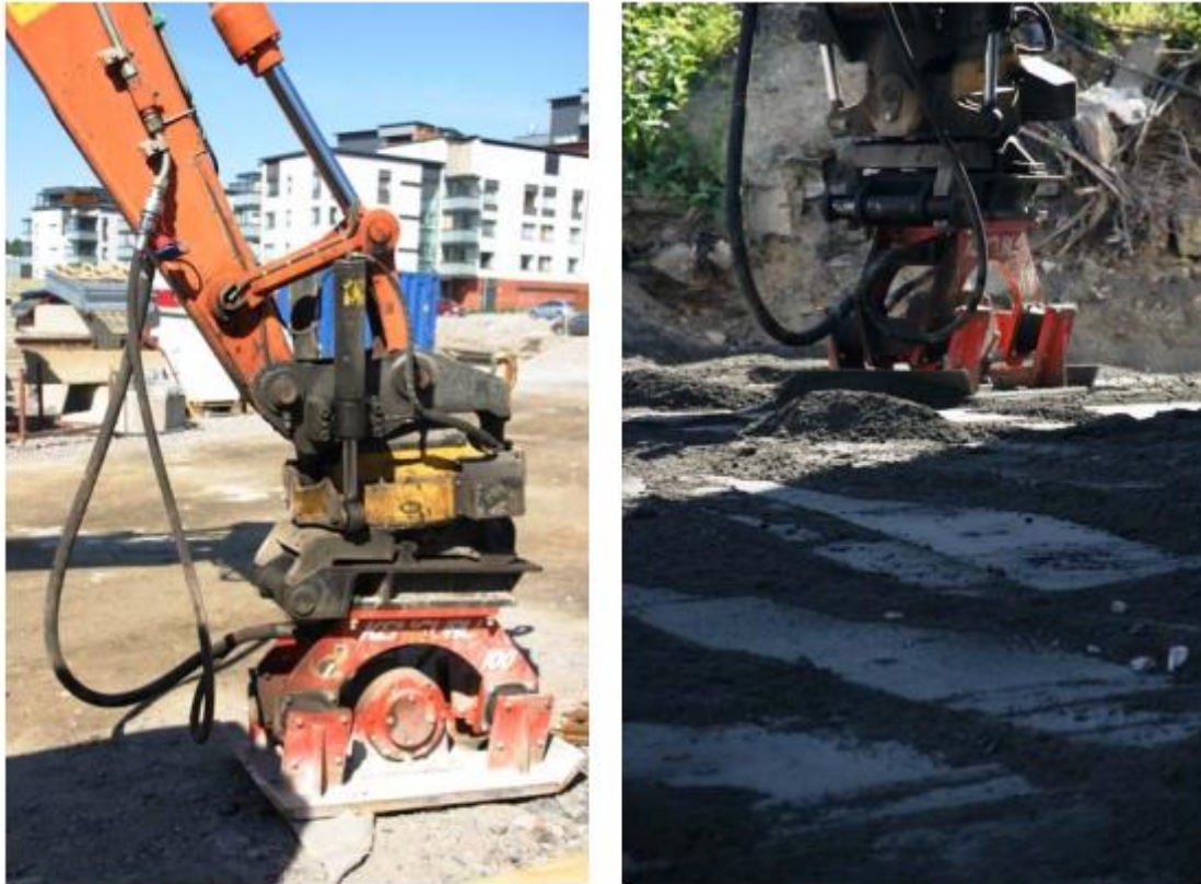
Kuva 4.6. Viikki, koerakenteet. Kaivinkoneeseen kiinnitettävällä hydraulitäryttimellä (täryvoima 9000 \text{ kg/m}^2 ) tiivistettiin osa pohjatuhkarakennekerroksista.
