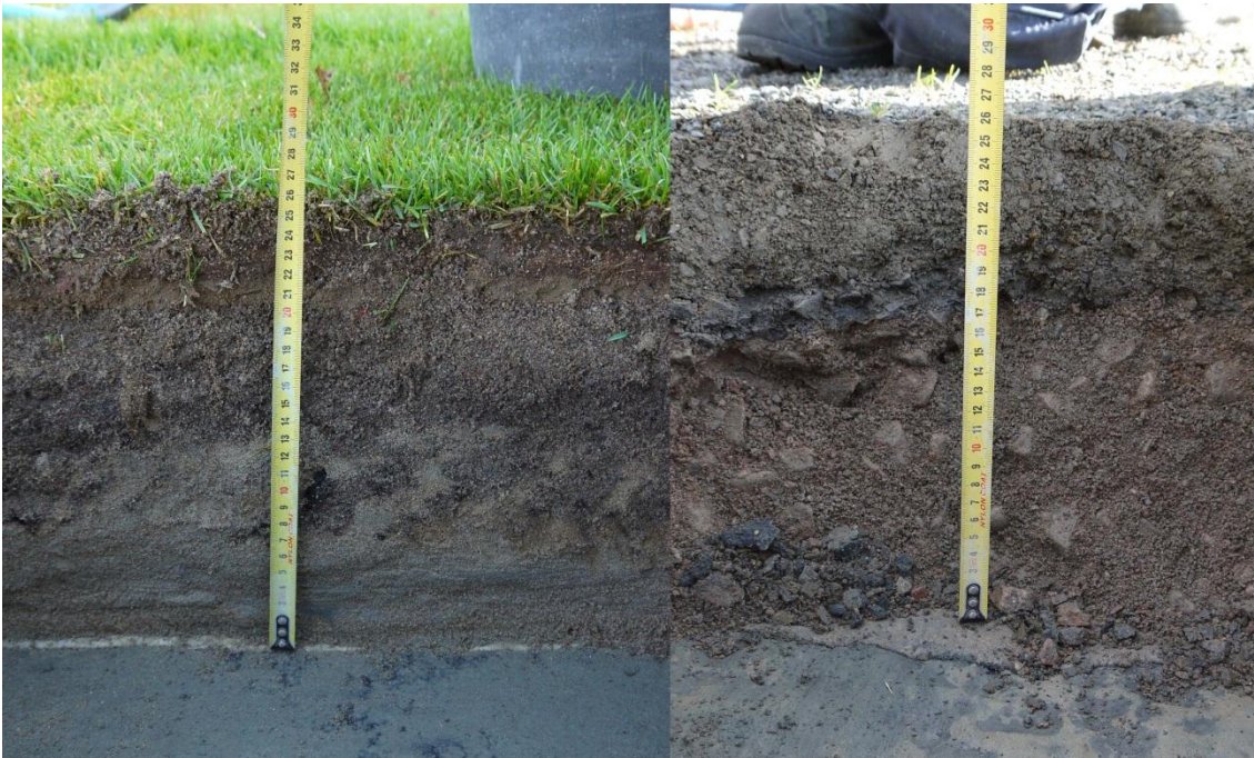
Kuva 3. Koekuopat rakennetutkimusta varten.
